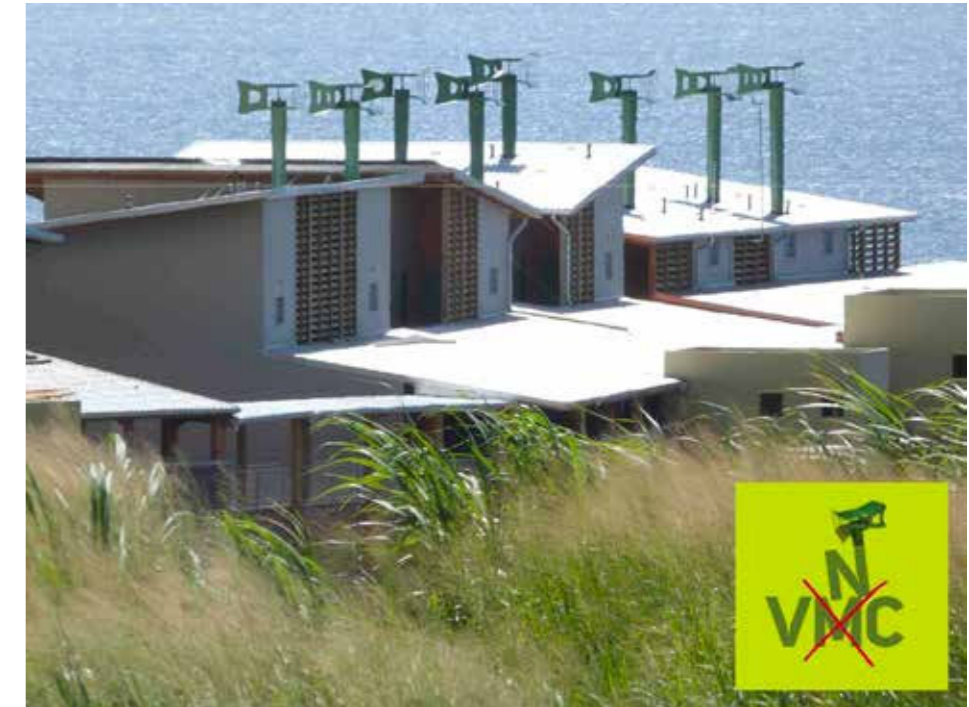
Figure 46 – La VNC (Ventilation Naturelle Contrôlée) remplace la VMC (Ventilation Mécanique Contrôlée). Expérimentation sur les logements « Les portes de Beauséjour »
