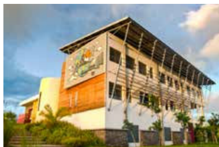
Figure 9 – ENERPOS : Premier bâtiment tertiaire à Énergie Positive dédié à l'enseignement construit sous les tropiques en 2008 11
