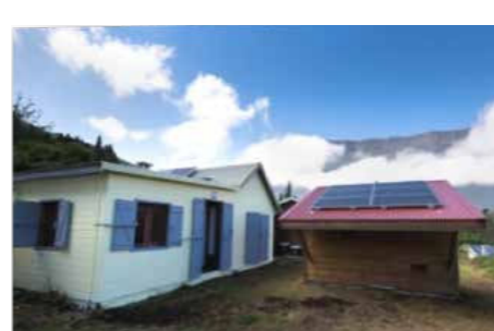
Figure 11 – Projet EDF de micro-grids 100% solaires à Mafate basé sur le stockage par batteries à hydrogène 13
