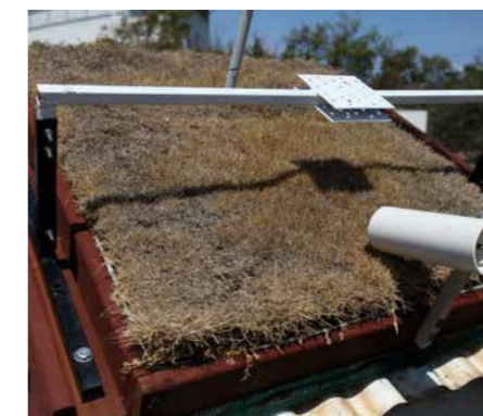
Figure 20 – Test de gazon en toiture
