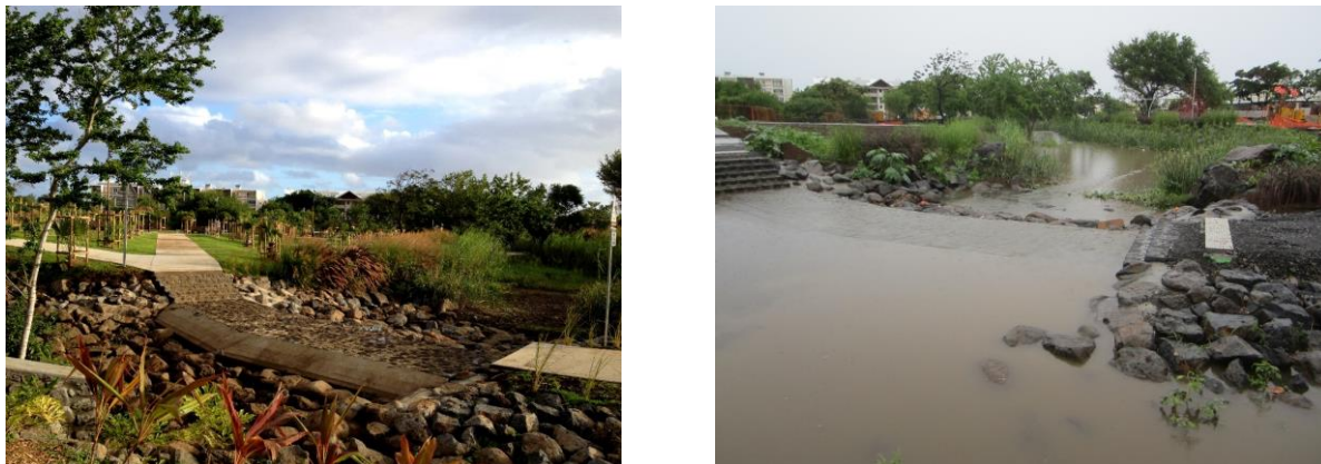
Figure A.8. 1 : Principe des bassins de rétention mis en œuvre dans le parc urbain du quartier de Ravine Blanche pour la gestion des eaux pluviales.
