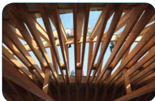
Vue sur « l'œil ». Le préau est éclairé par un soulèvement de la charpente bois © O. WOGENSKY
