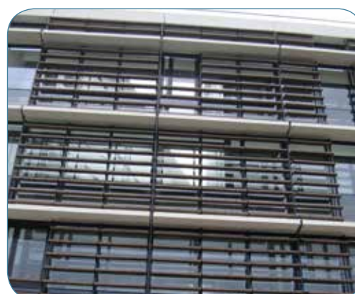
Double peau de la façade sud équipée de Brise-soleil en terre cuite et tablettes à lumière sur l'espace de circulation © Région Île-de-France, Unité Lycées
