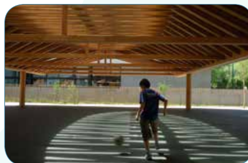
Vue sur « l'œil ». Le préau est éclairé par un soulèvement de la charpente bois © O. WOGENSKY
