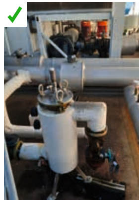
Mise en œuvre d'un clarificateur intégrant un filtre pour les particules non captées par le barreau magnétique. ©AQC
