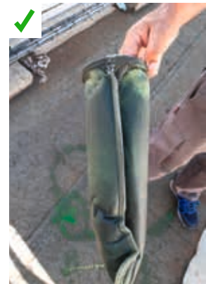
Mise en œuvre d'un clarificateur intégrant un filtre pour les particules non captées par le barreau magnétique. ©AQC
