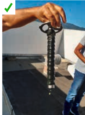
Le barreau magnétique du filtre clarificateur permet de capter les particules métalliques en suspension. ©AQC
