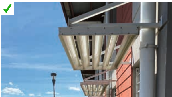
Fixation de la casquette assurant une reprise complète des forces.
