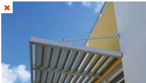
Les casquettes ajourées forment un brise-soleil fixé uniquement par le haut et en traction. Si les casquettes venaient à se soulever sous l'effet d'une secousse sismique ou d'un vent cyclonique, l'ensemble pourrait tomber et blesser des personnes.
