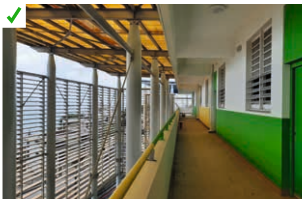
L'architecte a profité de la restructuration du bâtiment pour ajouter d'importants dispositifs protégeant les coursives et la façade : couverture en polycarbonate coloré limitant les rayonnements solaires et grands panneaux verticaux composés de lames brise-soleil fixes horizontales. ©AQC
