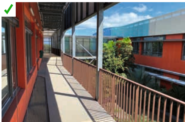
La couverture de cette coursive protège efficacement la façade, grâce à une retombée métallique sous forme de bandeau périphérique. ©AQC
