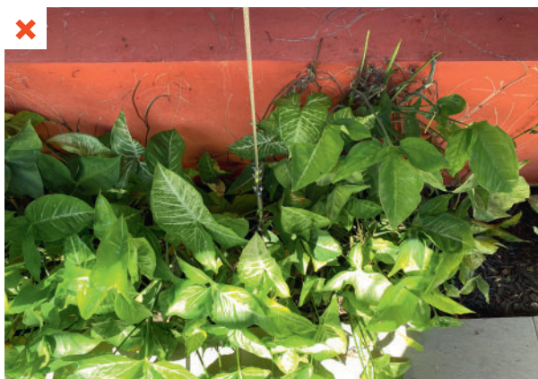
Plantes non adaptées au tuteur (câble) et se développant directement sur la paroi pouvant entraîner sa dégradation.
