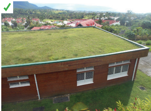
La toiture végétalisée fait partie de la stratégie globale de protection solaire et de rafraîchissement. ©Equinoxe
