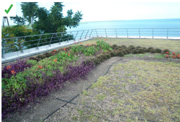
Toiture végétalisée avec un système d'arrosage en goutte à goutte permettant de préserver la végétation même lors de périodes plus sèches. ©AQC
