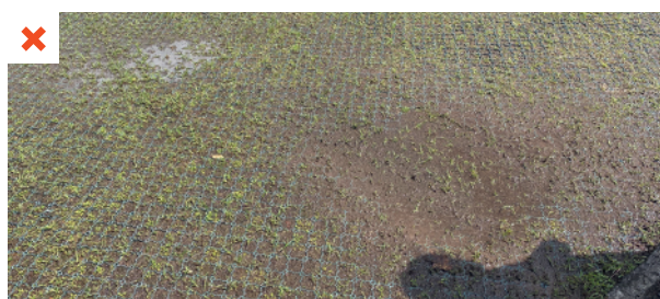
Disparition de la végétation mise en place du fait d'un défaut de drainage et d'un écrasement de la végétation par les véhicules dû. Le remplissage des alvéoles est trop important. ©AQC
