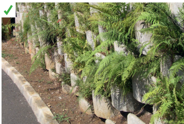
Talus végétalisé. Pour assurer le maintien du talus à forte pente, une structure maçonnée accueille la végétation. ©AQC
