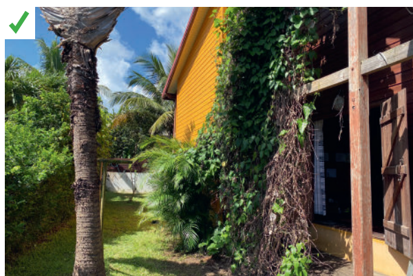
Façade partiellement végétalisée. ©AQC
