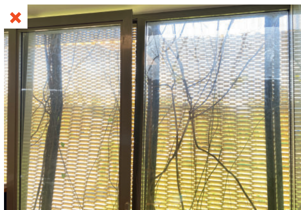
Prolifération de plantes grimpantes entre le bardage et la baie par manque d'entretien. ©AQC
