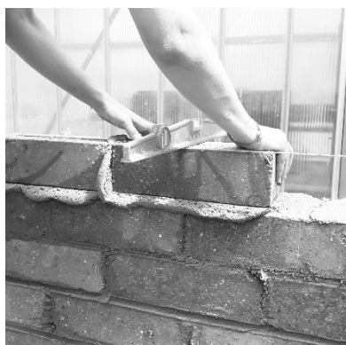
7. Contrôler l'horizontalité avec un niveau
