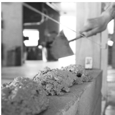
2. Disposer la juste quantité de mortier
