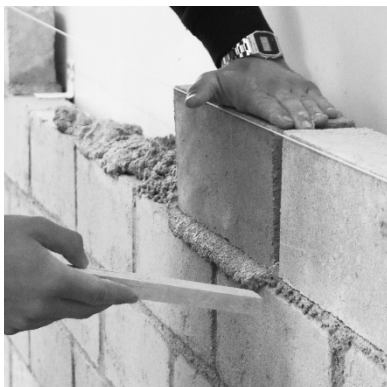
11. Retirer l'excès de mortier immédiatement
