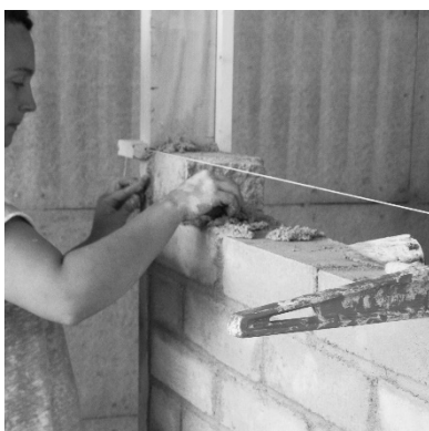
8. Contrôler l'alignement avec un cordeau
