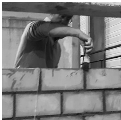
1. Humidifier le plan de pose
