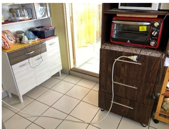
Exemple d'une cuisine où le manque de prise nécessite le branchement d'une rallonge alimentant par intermittence les équipements de cuisson électriques (mini-four et micro-onde)
