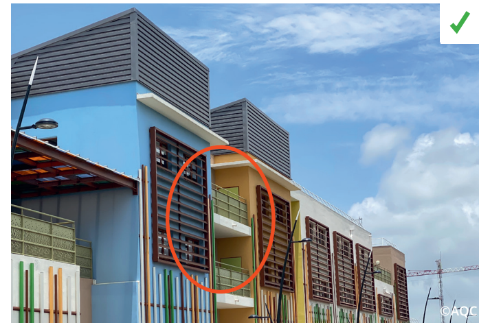
Brise-soleil en façade.
