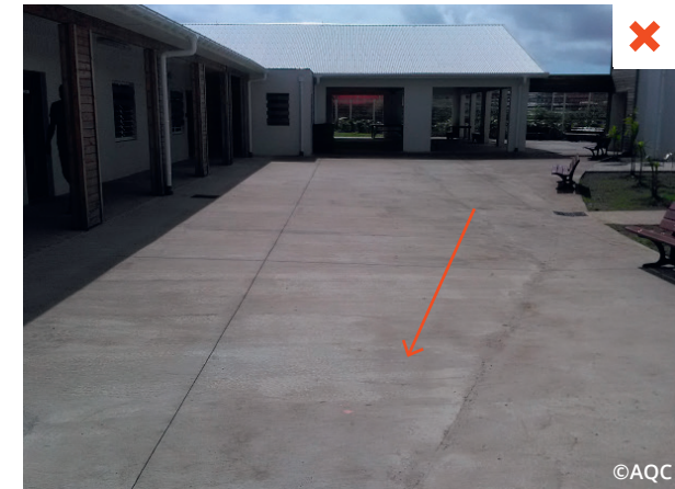
La cour est majoritairement minéralisée. De bonnes pratiques sont cependant à souligner : la couleur claire de la toiture et le débord de toiture assurant une protection solaire des façades.
