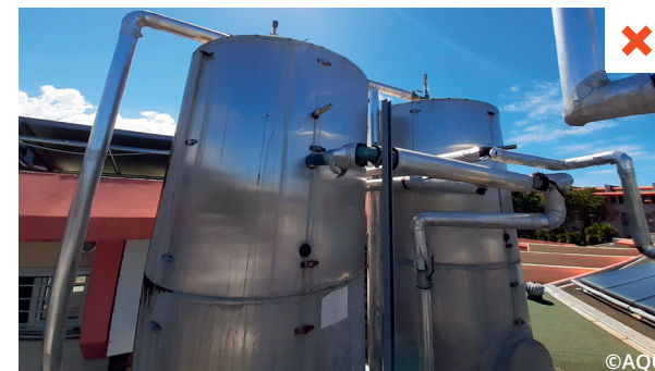
Capacité de stockage solaire de 2 500 litres
