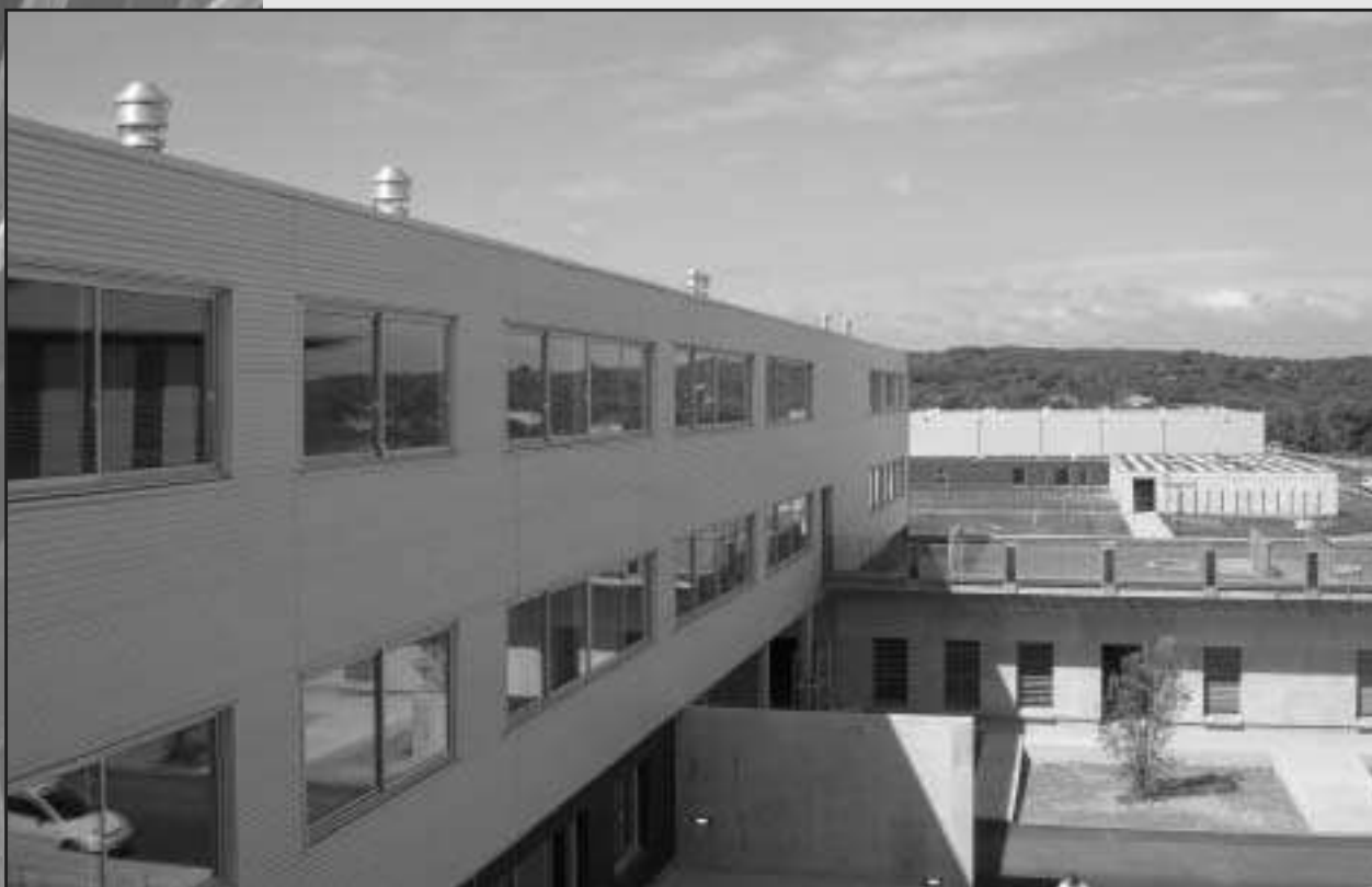
Lycée Jean-Vilar à Villeneuve-lès-Avignon (30)
