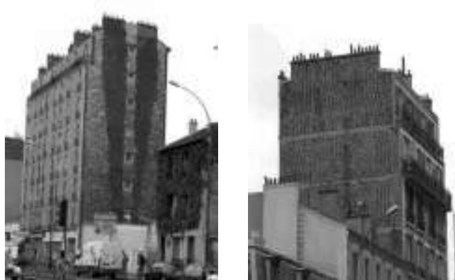
Figure 5.7 : conduits de fumée individuels
