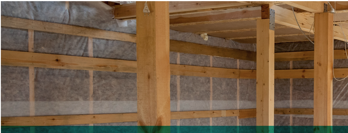
Figure 27 : Exemple de mur à ossature bois – Cas particulier d'un bâtiment à une altitude supérieure à 800 m
