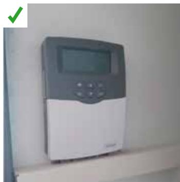
Exemple d'une interface de régulation simple avec des fonctions de base pour un usage par l'utilisateur final non expert. ©AQC
