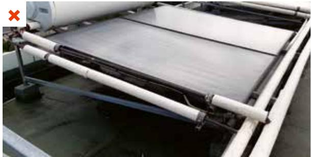
Calorifuge mal mis en œuvre laissant pénétrer l'eau de pluie qui le dégrade d'autant plus rapidement qu'il est aussi exposé aux rayons UV. ©AQC
