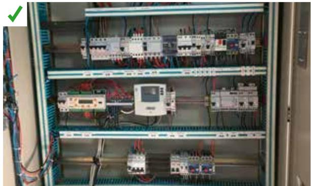
Exemple d'une régulation relativement complexe avec ajout d'une interface permettant une régulation plus simple, notamment pour les opérations de maintenance et de pilotage par l'utilisateur. ©AQC
