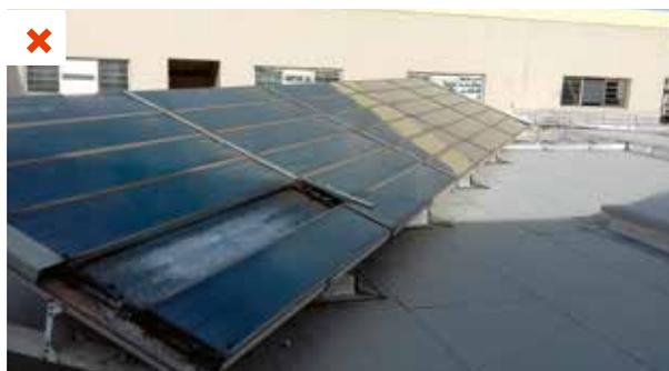
Dégradation du rendement de l'installation due à l'absence de maintenance et de remplacement des équipements endommagés. ©AQC
