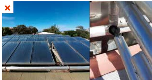
Surface utile de capteurs trop importante pour une cuisine satellite : une cuisine satellite nécessite un besoin en ECS nettement plus faible qu'une cuisine centrale. Après plusieurs années de fonctionnement, une partie des champs a été déconnectée du réseau (illustration de droite). ©AQC
