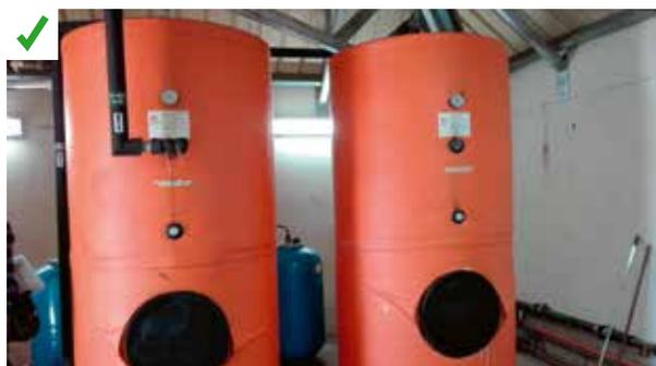
Suite au dimensionnement estimant un besoin de stockage supérieur à 1000 l, le choix s'est porté sur des ballons disposant d'un trou d'homme pour faciliter les interventions de maintenance. ©AQC
