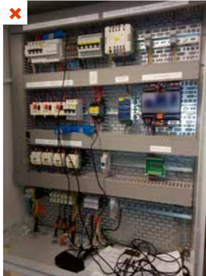
Absence d'interface pour cette régulation complexe. Les entreprises de maintenance et les usagers/exploitants ne peuvent pas suivre, contrôler et optimiser l'installation. ©AQC
