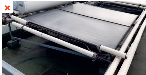
Calorifuge mal mis en œuvre laissant pénétrer l'eau de pluie qui le dégrade d'autant plus rapidement qu'il est aussi exposé aux rayons UV. ©AQC
