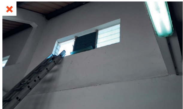
Absence d'accès sécurisé à la terrasse pour la maintenance de l'installation solaire. ©AQC
