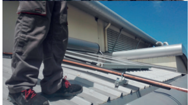
L'installation collective en ECS alimentant plusieurs blocs de douches d'un gymnase a été remplacée par des chauffe-eau solaires individuels (1 monobloc par bloc de douches). Cette option a été retenue suite à l'analyse des consommations et la difficulté d'entretien de l'installation (longueur de réseau, multiplication des organes de régulations...). ©AQC
