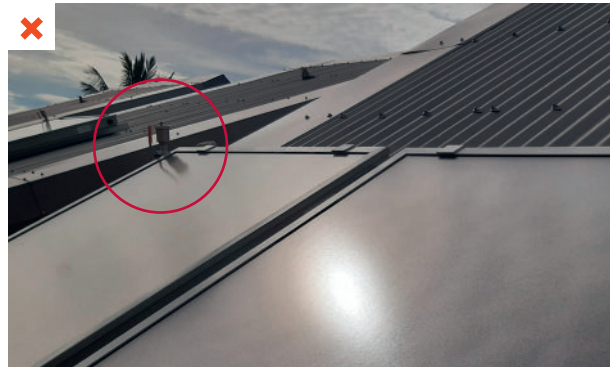
Purgeur automatique d'intérieur mis à l'extérieur avec une température maximum de 110 °C insuffisante pour supporter les fortes températures en stagnation. ©AQC
