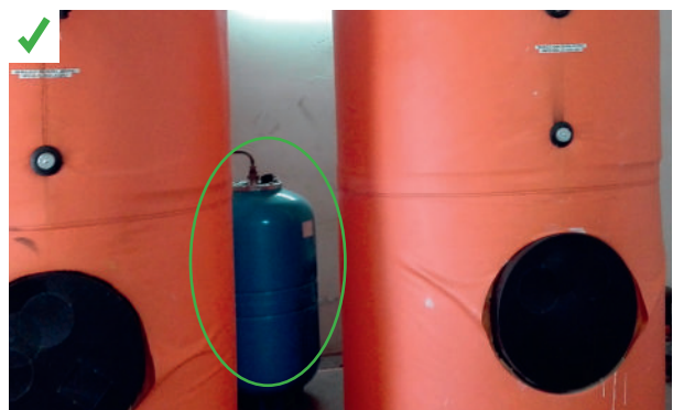
Vases d'expansion correctement dimensionnés et mis en œuvre. ©AQC
