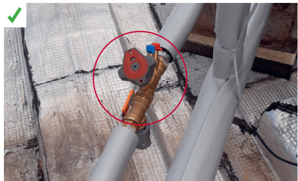
À l'exception du compteur et des doigts de gant (entourés en rouge), le calorifugeage est continu, les jonctions et coudes ont été traités. Idéalement, des calorifuges thermoformés pour les compteurs et doigts de gant permettraient de compléter le dispositif. ©AQC
