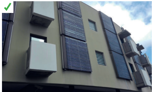
Dans le cas de cette installation, une déconnexion des capteurs en cas de surchauffe est possible. ©AQC
