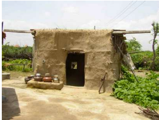
Figure 8 : Bhunga en pisé stabilisé (Chiodero, 2008, p. 25)
