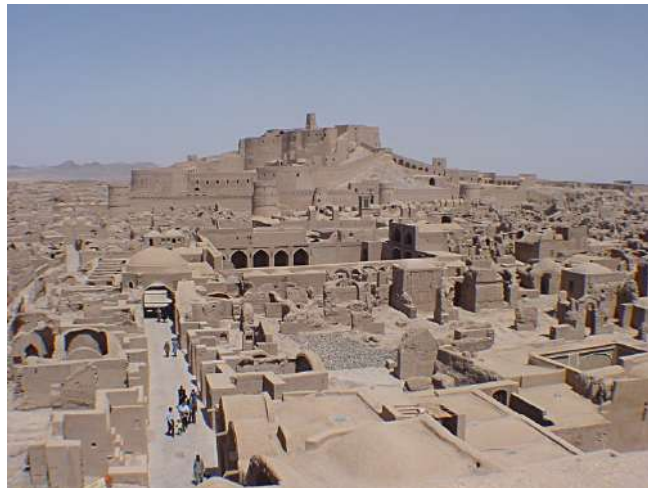
Figure 2 : Citadelle de Bam avant le séisme. Elle est entièrement construite en terre crue et en particulier c'est la technique de l'adobe qui a été utilisée
