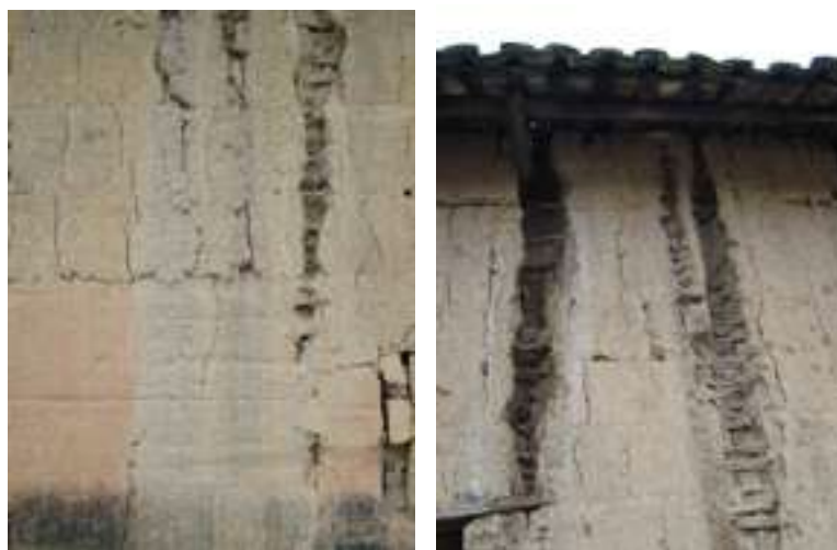
Figure 11 : Renforts horizontaux dans les murs (Ostrowski, 2009)
