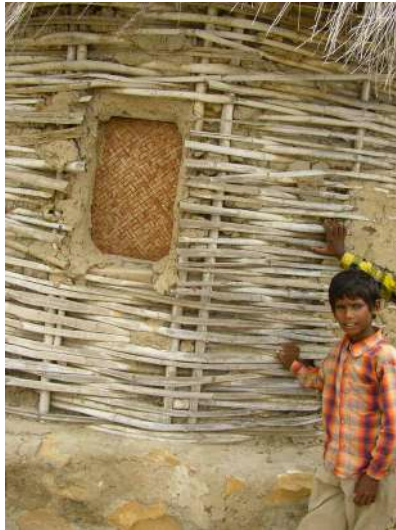
Figure 7 : Bhunga renforcée avec bambou (Chiodero, 2008, p. 24)
