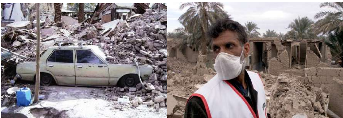
Figure 4 : Images de la destruction de la ville de Bam. On remarque les murs en adobe complètement détruits
