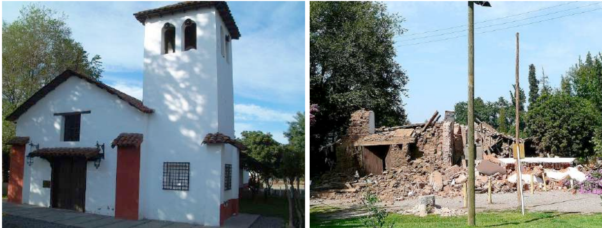
Figure 24 : Eglise « Inmaculada Concepcion », la Campaño (Chile), avant et après le séisme du 27.02.2010
