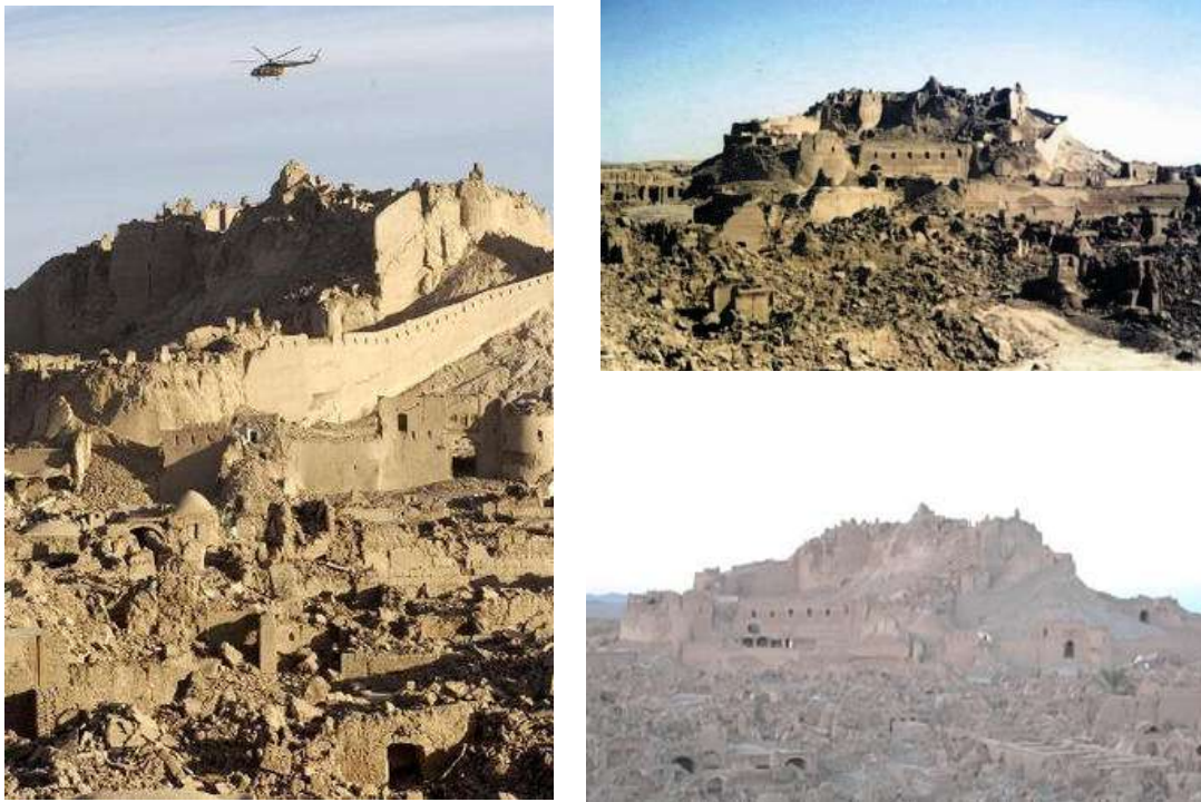
Figure 3 : Ancienne citadelle de Bam après le séisme du 2003
