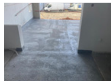
Étanchéité du sol du bâtiment
