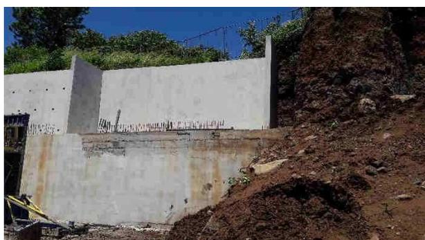
Figure 29: Mur de soutènement en béton
