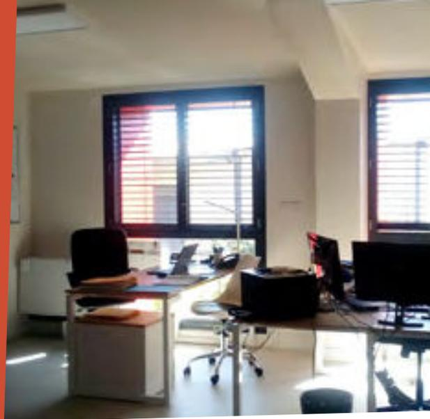
Les BSO permettent de s'adapter aux besoins des occupants et aux conditions d'ensoleillement © EnvirobatBDM
