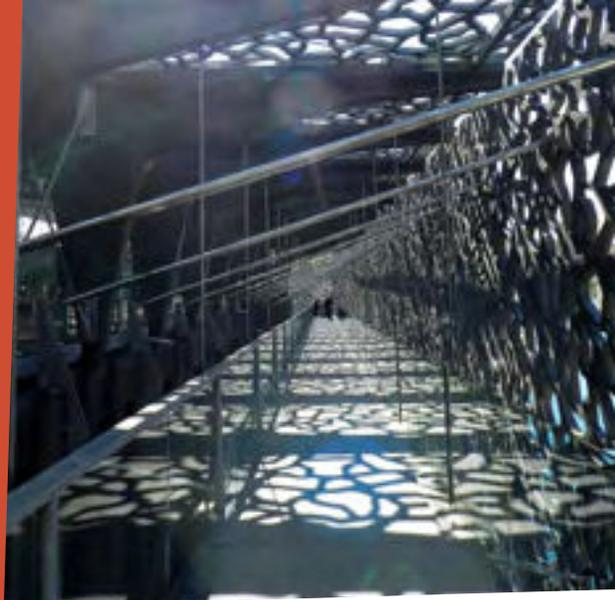
Mucem : résille en béton, faisant office de protection solaire.
