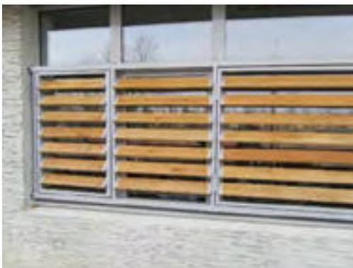
Protection solaire fixe avec partie ouvrante pour nettoyage. © Inddigo
