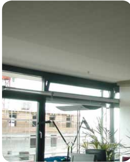
Dans les bureaux l'air entre par les impostes.
