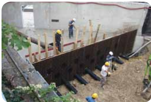
Les tuyaux sont posés, d'un seul tenant entre deux chambres enterrées.
