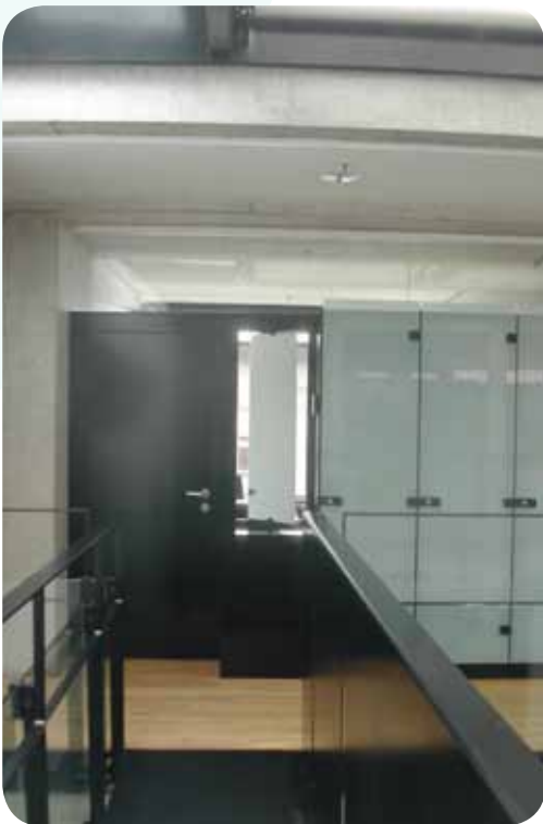
Un volet (en blanc) pilotable par l'occupant du bureau laisse passer l'air de la façade à l'atrium.
