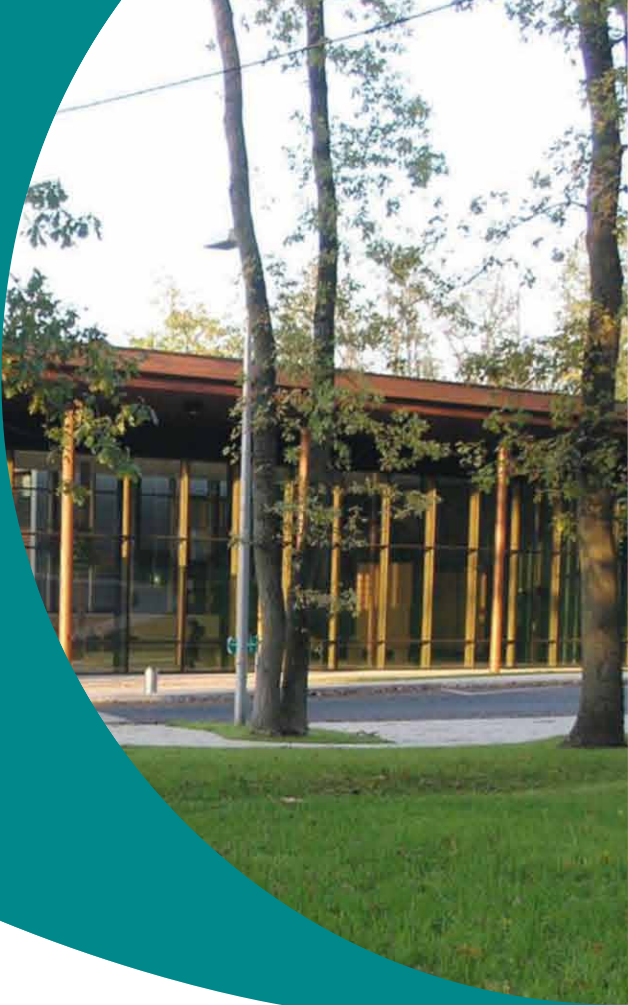
PÔLE D'ACCUEIL DE L'INERIS - Hall d'accueil ventilé naturellement
