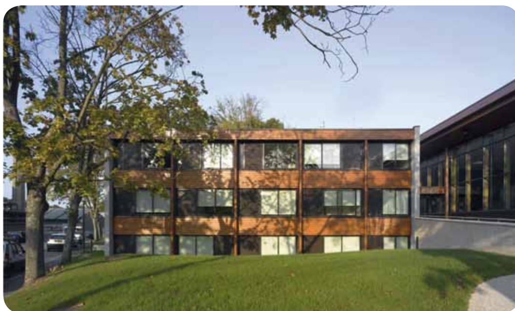
Bureaux du pôle accueil-formation de l'INERIS - Maître d'ouvrage : INERIS - Maître d'œuvre : ARVAL - BE HQE : TERAQ
