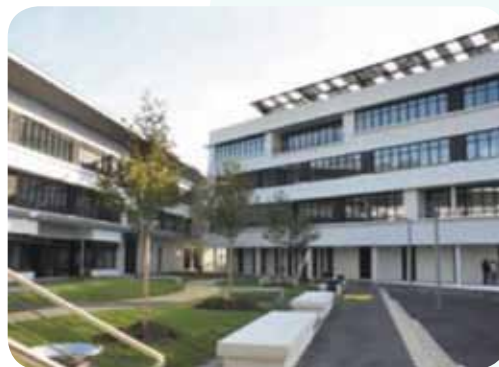
Les tuyaux sont posés sous la cour. Ils sont enfouis dans la terre trouvée sur le terrain, celle-ci étant particulièrement favorable à l'échange.
