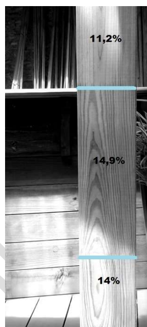
Figure 82 - Poteau abouté, mesures d'humidité moyennes du bois suivant les différents aboutages de la première face
