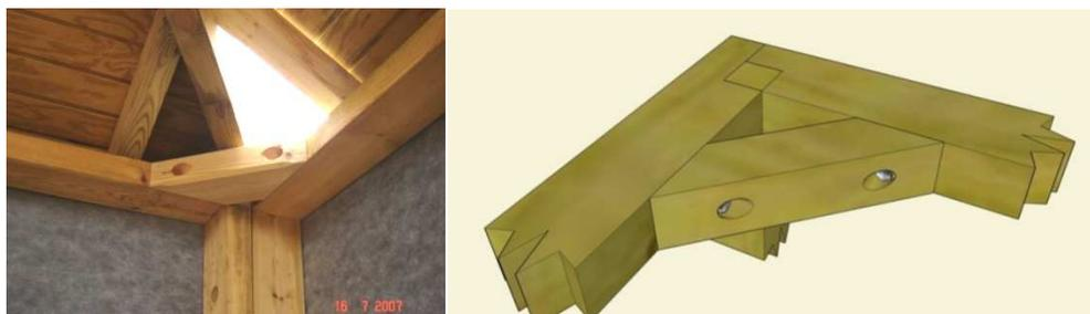
Figure 36- Photographie et schéma de principe des renforts de liaison des traverses aux angles de façades
