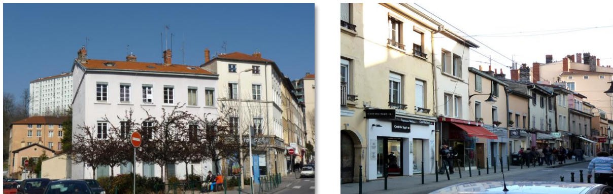
Figure 7: Lyon, Quartier Saint Just (à gauche) et Croix-Rousse (à droite), immeubles en pisé,
