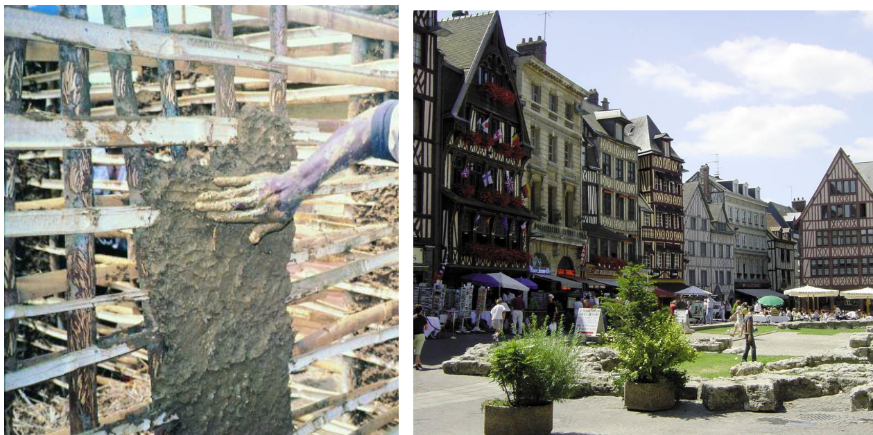
Figure 11: à gauche, exemple de mise en oeuvre d'un torchis sur ossature bois ( http://fermegessienne.canalblog.com ); à droite, la place du vieux marché à Rouen.
