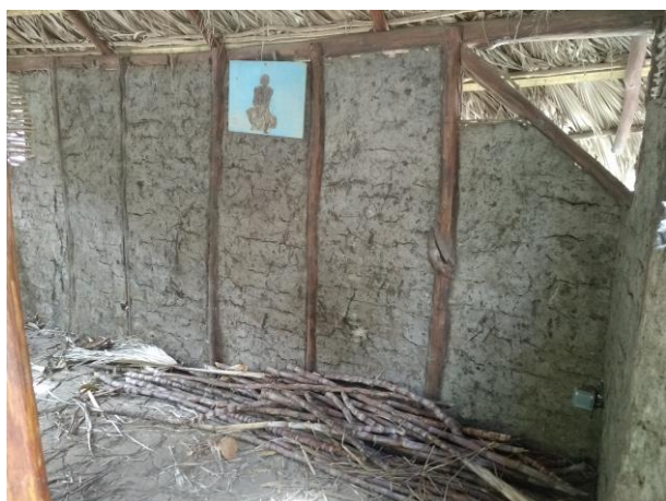
Figure 30: De gauche à droite et de bas en haut : Case à gaulette; Tressage en bambou sur une parois de case; Torchis de bouse de vache sur bois ti-baume; enduit lait de chaux sur torchis. (L'ensemble des photos ont été réalisées par T.Vinceslas à la Savanne des Esclaves
