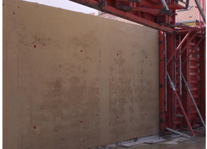
Figure 10: Mise en œuvre de terre coulée et décoffrage (Construire en terre crue – Terre coulée)
