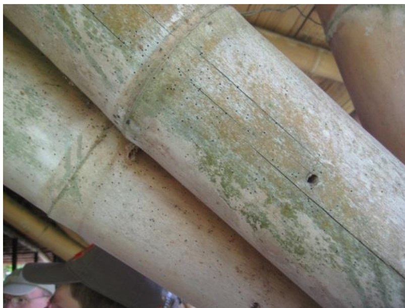
Figure 16: Attaque de coléoptère. Les trous de sortie sont visibles
