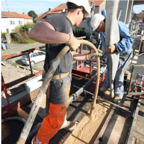
Figure 10: Mise en œuvre de terre coulée et décoffrage (Construire en terre crue – Terre coulée)
