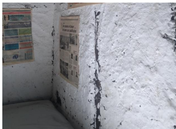
Figure 30: De gauche à droite et de bas en haut : Case à gaulette; Tressage en bambou sur une parois de case; Torchis de bouse de vache sur bois ti-baume; enduit lait de chaux sur torchis. (L'ensemble des photos ont été réalisées par T.Vinceslas à la Savanne des Esclaves
