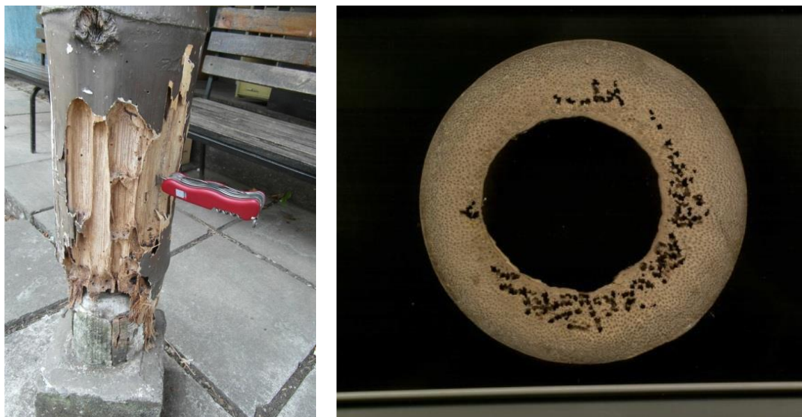
Figure 17 : Attaque sévère de termites (gauche); section d'une chaume de bambou attaqué par les termites (droite).
