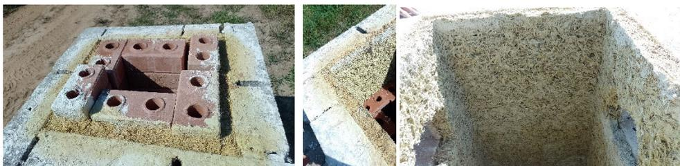
*Matériau isolant mis en œuvre par banchage (matériau banché ; retrait des briques de coffrage ; résultat final)*
