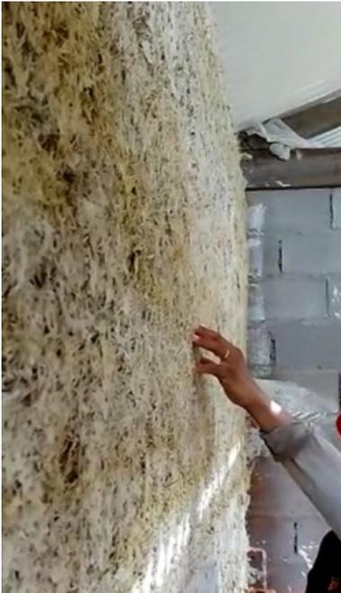
Finalement, le matériau fibreux isolant a été mis en œuvre par coffrage. Des banches de bois ont été montées, en remplacement des BTCS déclassés expérimentés comme banches dans les « niches de test ».
