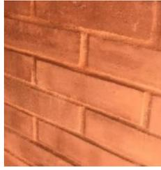
Figure 22 : Mortier de rejointoiement à base de terre
