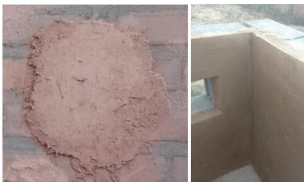
Figures 17 et 18 : Enduit isolant terre-fibres
