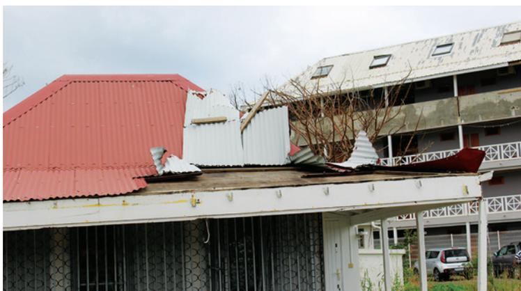
*Figure 6 : Soulèvement en bord de toiture - tôle trop fine et pas assez raide, fixation ponctuelle entraînant une perforation*
