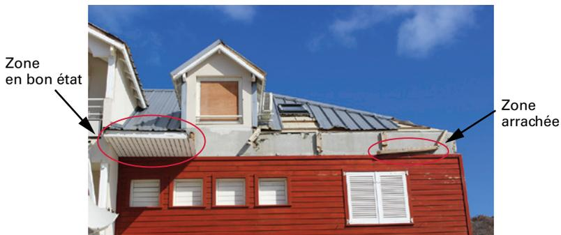
Figure 4 : Débord de toiture sous-dimensionné
