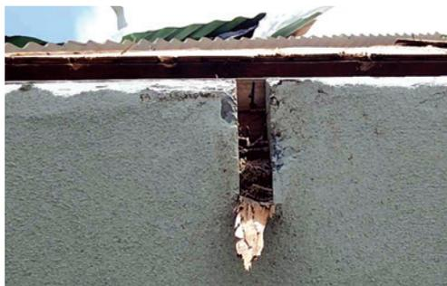
Figure 10 : Mauvaise fixation de la charpente au chaînage
