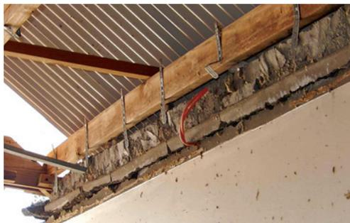
Figure 11 : Mauvaise fixation (plats mal ancrés)
