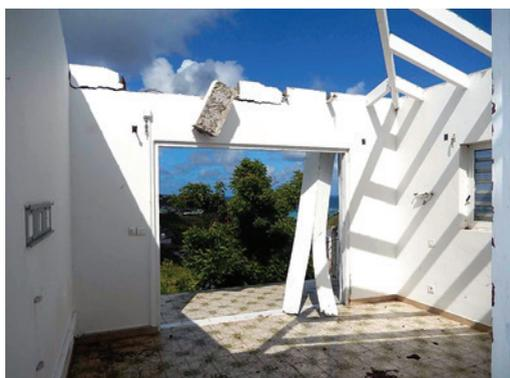
*Figure 13 : Mauvais assemblage à la maçonnerie et absence de contreventement pour une charpente à 4 versants*
