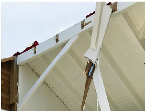
Figure 5 : Mauvais assemblage
