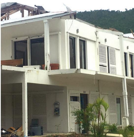
Figure 3 : Fixation insuffisante des volets
