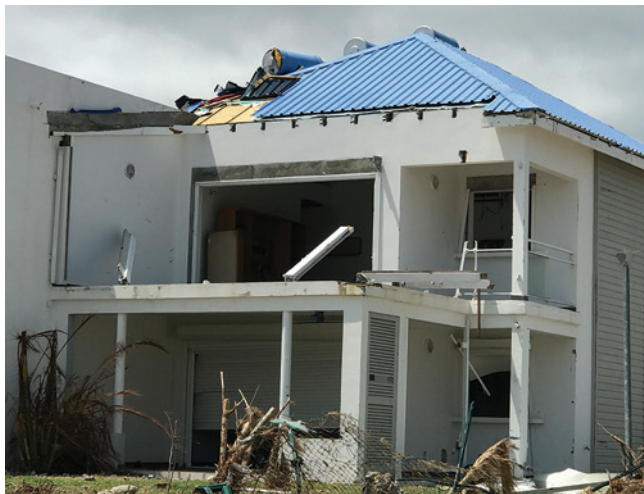
Figure 1 : Auvent arraché
