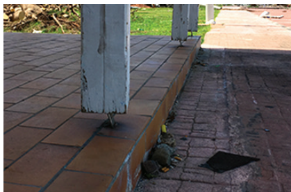
Figure 5 : Flexion des pieds de poteaux
