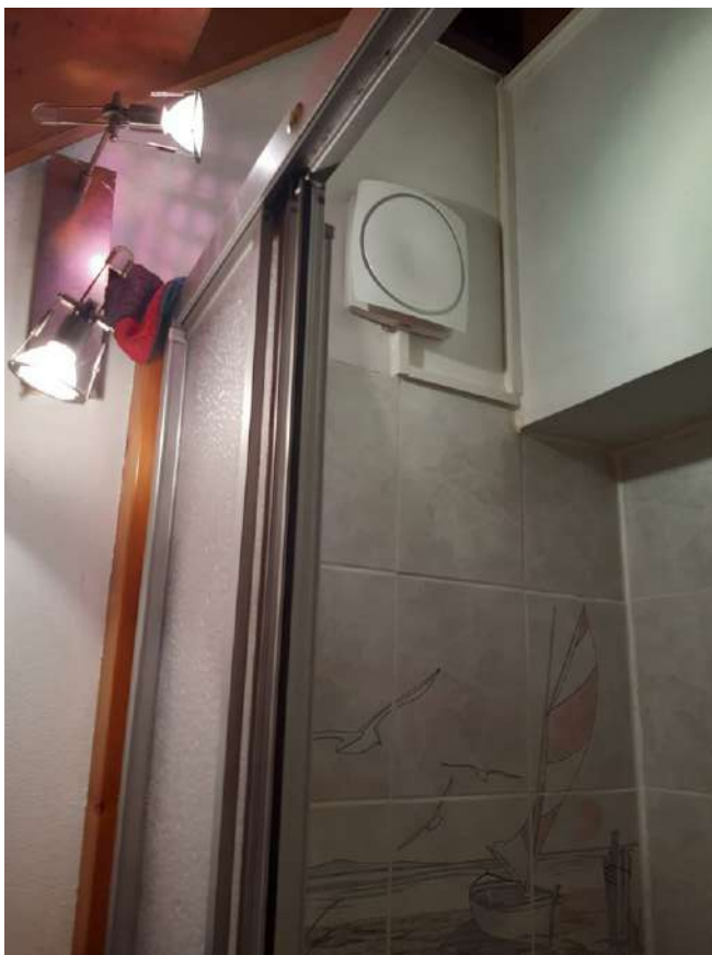
Un extracteur d'air dans la salle de bains moins efficace qu'une VMC
