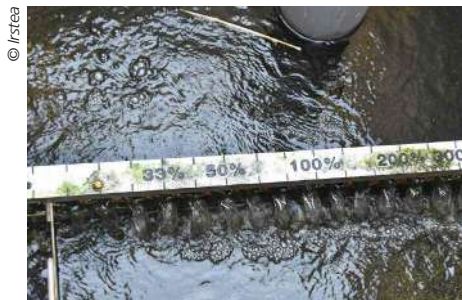
Figure 6. Lame crénelée pour recirculation manuelle.
