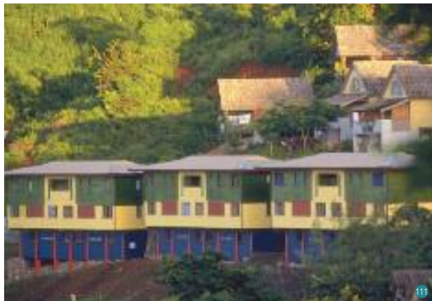
Cavani, lotissement Vetiver, 1999 Réalisation : Société immobilière de Mayotte.
