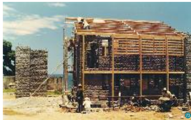
Sada, chantier de construction de la mairie, 1984 Réalisation : Atelier mahorais d'architecture, Thierry Legrand.
