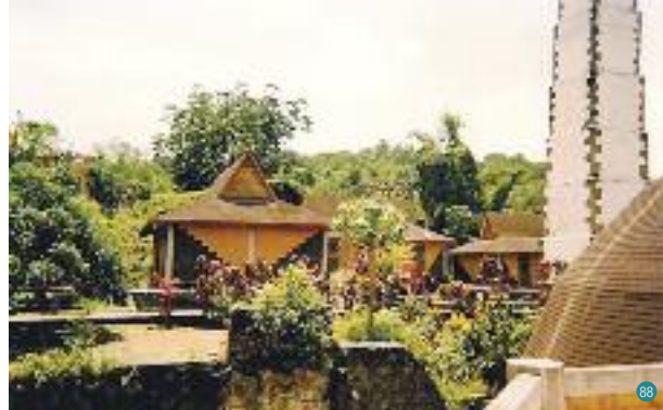
Collège de Dzoumogné, construit en 1985 La cheminée de l'usine sucrière est conservée au sein de l'établissement scolaire. Réalisation : Atelier mahorais d'architecture, Léon-Attila Cheyssiak.
