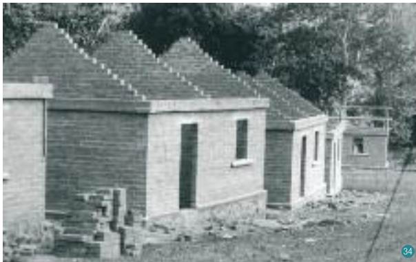
Dzoumogné, chantier de construction de cases Sim, 1990
