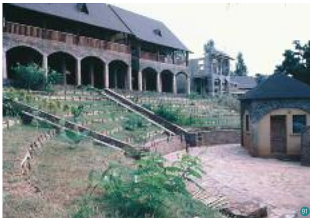
Mamoudzou, lycée Younoussa Bamana, construit en 1981-1982 Réalisation : Atelier mahorais d'architecture, Léon-Attila Cheyssial.
