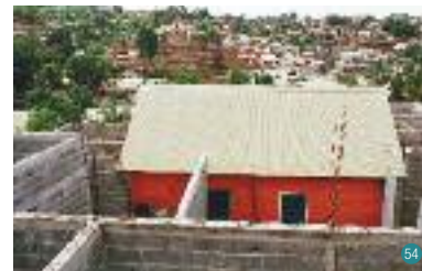
Case Sim en cours d'extension, 2004 Extension d'une case Sim selon de nouveaux procédés de construction (parpaing de béton).
