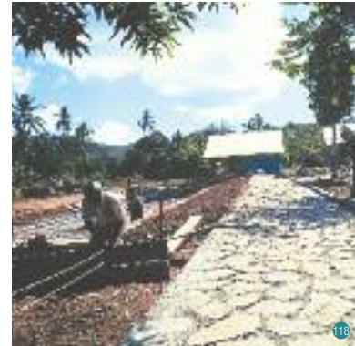
Pavage des chemins et rues et installation des assainissements
