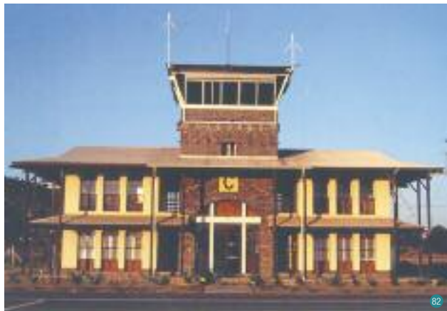
Pamandzi, tour de contrôle de l'aéroport Réalisation : Direction de l'Équipement, Pascal Rollet.
