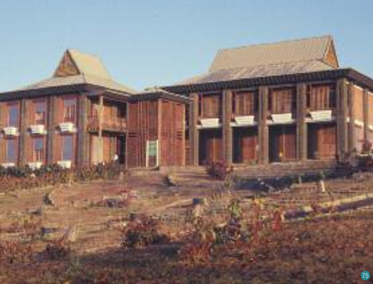
Mamoudzou, bâtiment de la Préfecture de Mayotte, construit en 1985 Réalisation : Atelier mahorais d'architecture, Léon-Attila Cheyssial.
