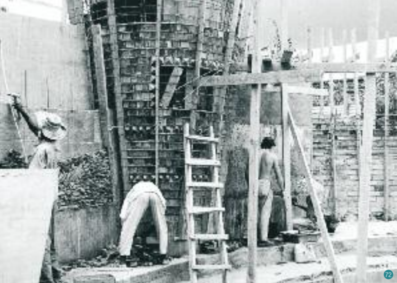
Mamoudzou, chantier de construction de l'hémicycle du Conseil général, 1990 Réalisation : Atelier mahorais d'architecture, Léon-Attila Cheyssial.
