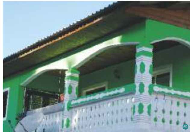
Mroalé, détail de façade d'une maison contemporaine, 2016
