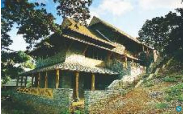
Mamoudzou, lycée Younoussa Bamana, construit en 1981-1982 Réalisation : Atelier mahorais d'architecture, Léon-Attila Cheyssiak.
