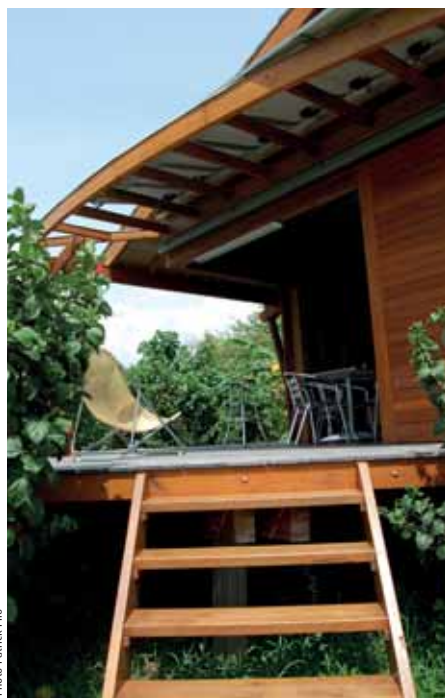
Le gîte «Écolola» Darviot utilise du bois pour tous les éléments : poteaux de soutienement (ipé du Brésil), structure (pin traité classe 4), bardage (douglas), tuiles (châtaignier).
