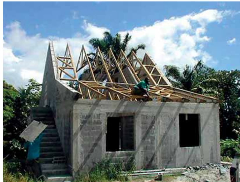
Maison parasismique (murs de contreventement en façade et poutre-au-vent en toiture).
