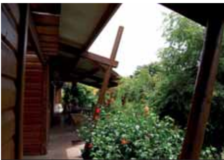
Maison Darviot, à Goyave: débords de toiture et végétation pour protéger une façade sud.
