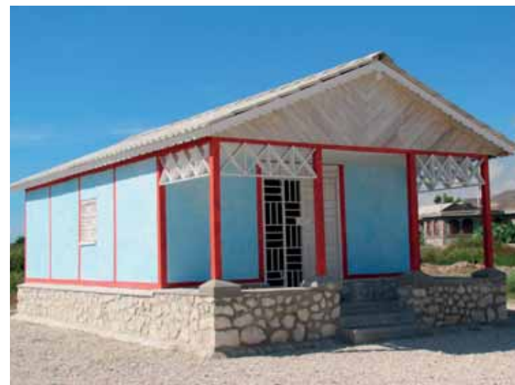
Modèle de construction individuelle parasismique en Haïti.
