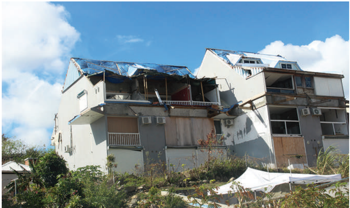
Figure 3 : Désordres sur parties légères d'ouvrages maçonnés
