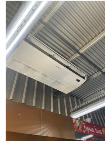
Figure 14 : Toiture sous tôle non isolée d'un commerce de Sainte-Suzanne
