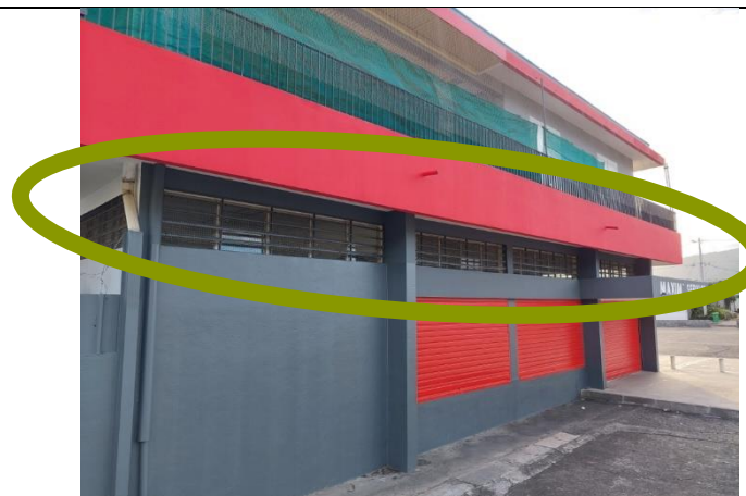
Figure 16 : Photo des ouvertures d'un commerce
