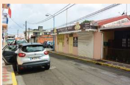
Bâtiments vacants (vue n°1)
