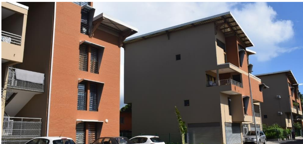
Façade est sur rue
