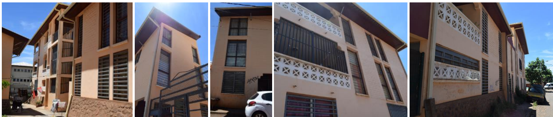
(1) Jalousies toute hauteur sur les chambres doublées de grilles (insécurité). (2-3-4) Peu de protection solaire sur les baies : les occupants ont ajouté des rideaux intérieurs pour limiter le rayonnement solaire. (4) Façade donnant directement sur la rue : abords du bâtiment bitumés et sans végétation.
