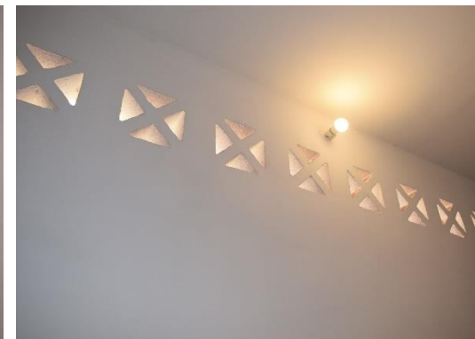
Opération Doujani : les moucharabiehs permettent de garantir une ventilation naturelle en continue tout en se préservant contre les intrusions et en protégeant l'intimité. Parfois les moucharabiehs sont doublés de moustiquaires pour éviter les insectes.
