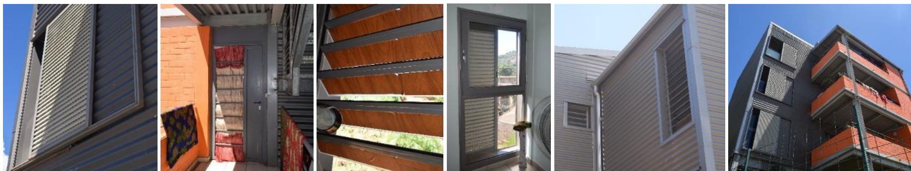
(1) Volets persiennés (porosité très faible). (2) Porte des logements grillagées mais obstruées par les habitants. (3) Jalousies en glace claire et protections ajoutées par les occupants. (4) Porosité des chambres faible (la moitié inférieure de la baie est fixe). (5) Jalousies de couleur claire sur la façade arrière ne respectant pas le facteur solaire. (6) Tôle couvrant les varangues du dernier niveau non isolée.
