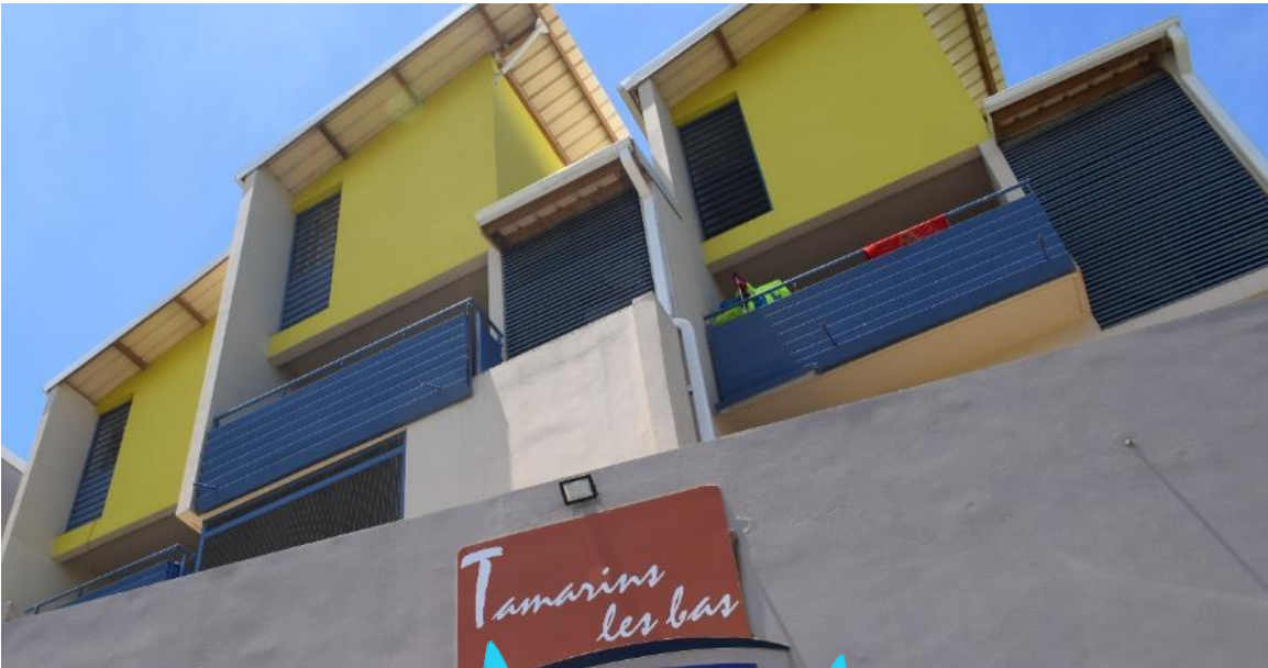
Façade ouest du bâtiment E
