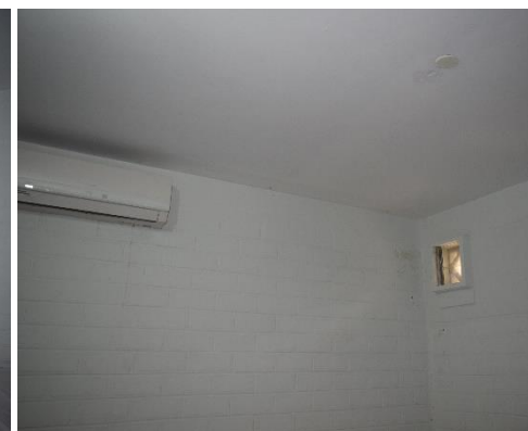
Opération Trevani Mix : dans une chambre climatisée, il a été prévu une attente pour brasseur d'air au plafond mais l'utilisateur utilise un ventilateur sur pied
