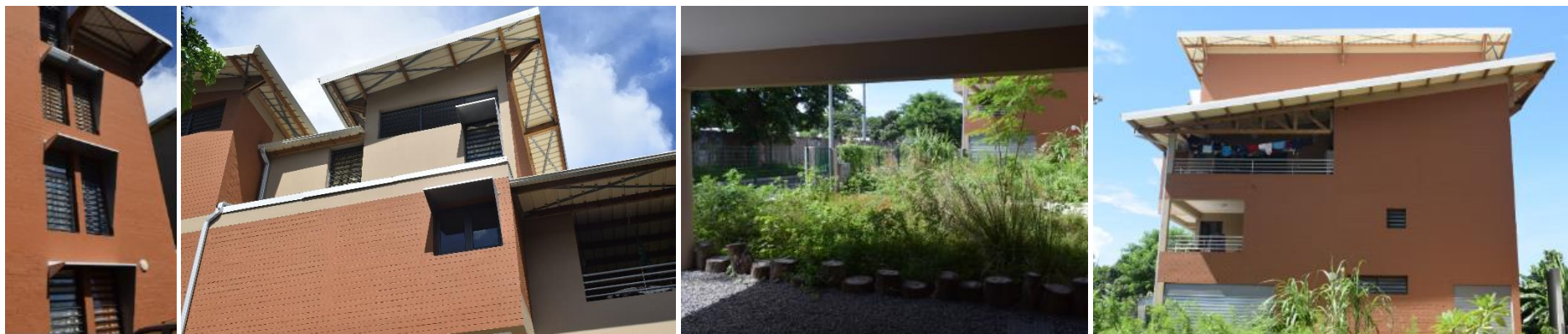
(1-2) Jalousies en vitrage clair protégées par des casquettes et joues. (3) Jardins entre les bâtiments (végétaux comestibles). (4) Toiture tôle sans isolant sur les varangues du dernier niveau.
