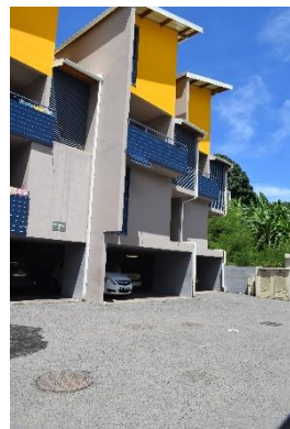
Opération Tamarins les Bas : parking bitumé au centre de l'opération
