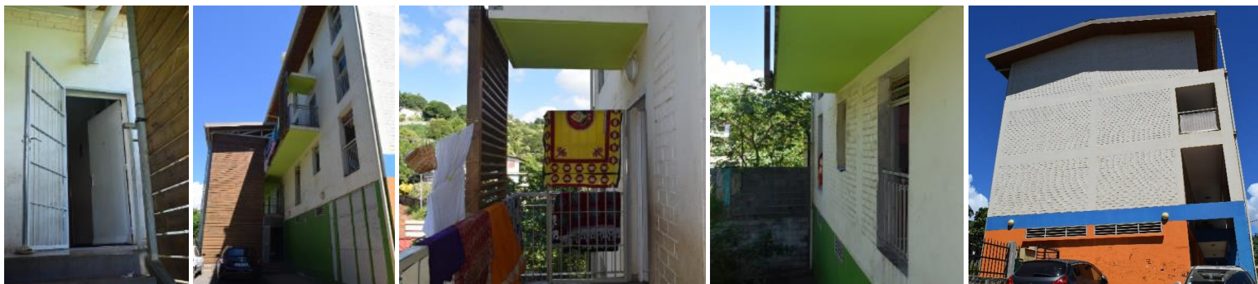
(1) Double porte grillagée (porte pleine souvent ouverte). (2) Coursive servant à la protection solaire sur la façade arrière. (3) Brises soleil devant la porte d'entrée. (4) Façade arrière. (5) Pignon en béton au RDC et en BTC aux étages supérieurs.
