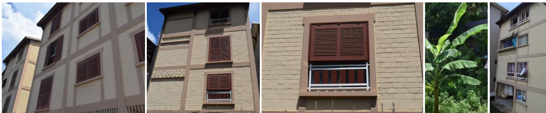
(1-2-3) Jalousies protégées par des volets bois persiennés projetables côté rue. (4) Jardin à l'intérieur de l'opération. (5) Jalousies en vitrage clair non protégées sur les façades intérieures.
