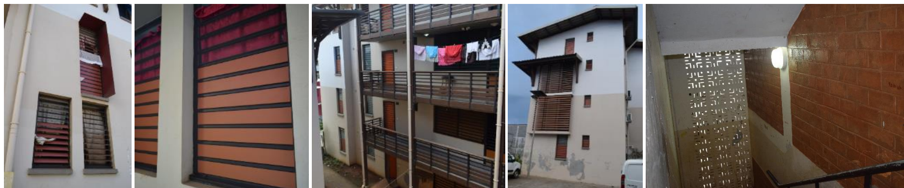
(1) Jalousies en vitrage clair en partie haute et lames opaques en partie basse. (2) Les occupants ont ajouté des rideaux intérieurs pour l'intimité (3) Double porte grillagée (fermée). (4) Pignon exposé (doublement intérieur isolant). (5) Mur en BTC dans les escaliers.
