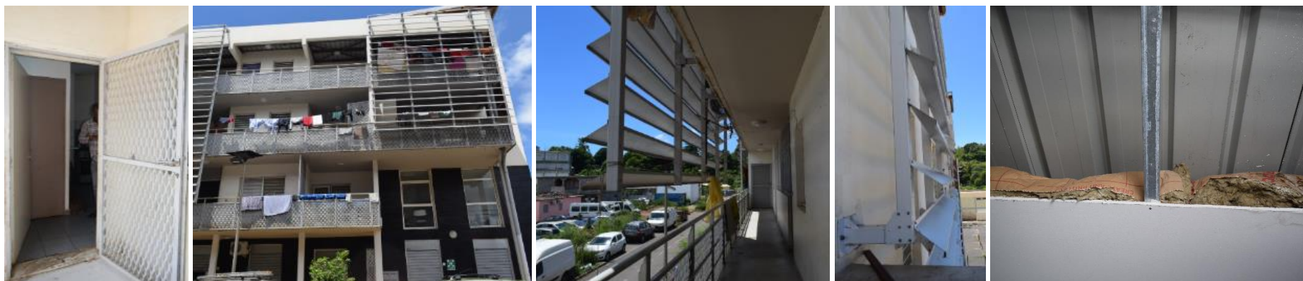
(1) Double porte grillagée en métal déployé (généralement ouverte) (2-3) Brise soleil sur la façade côté coursive. (4) Brise soleil sur la façade arrière. (5) Isolant en toiture.
