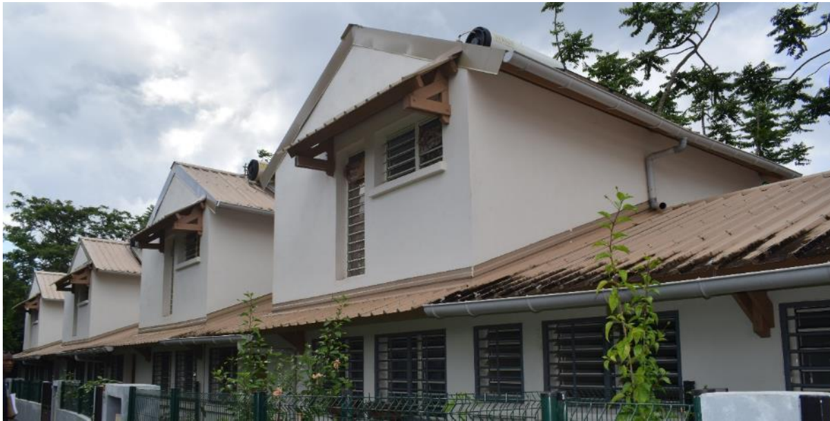
Façade sud du bloc A
