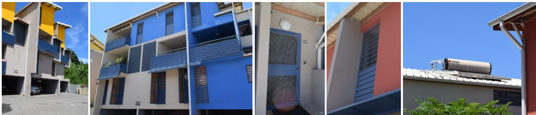
(1) Abords des bâtiments bitumés. Parking sous les bâtiments. (2) Murs avec enduit de couleur foncée. (3) Double porte grillagée devant la porte d'entrée. (4) Jalousies toute hauteur sur les chambres avec vitrage clair en partie haute et opaque (tôle nue de couleur sombre) en partie basse. (5) Monobloc en toiture pour la production d'eau chaude.
