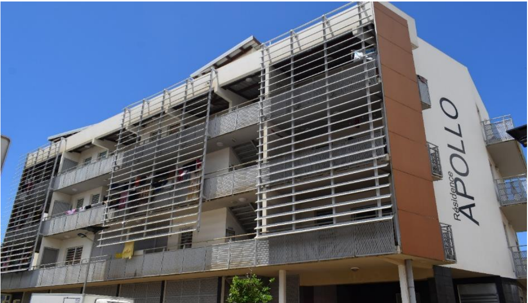
Façade sud sur rue
