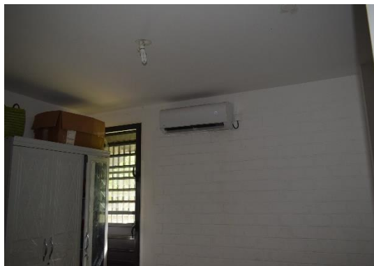
Opération Trevani Mix : attention à l'ameublement pour ne pas obstruer les baies servant à la ventilation naturelle
