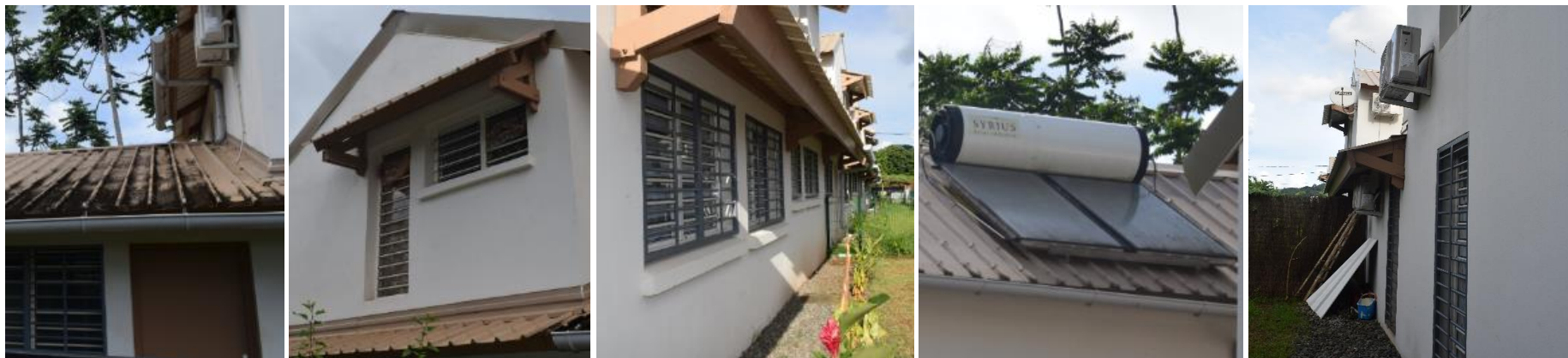
(1) Toitures de couleur claire empoussiérées. (2) Débords de faible profondeur sur les jalousies. (3) Végétalisation partielle des façades (végétation basse qui crée peu d'ombrage). (4) Eau chaude solaire en toiture. (5) Façade nord non protégée.
