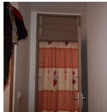
Opération Apollo : remplacement des portes par des rideaux qui permettent de garder l'intimité des chambres tout en favorisant la ventilation naturelle
