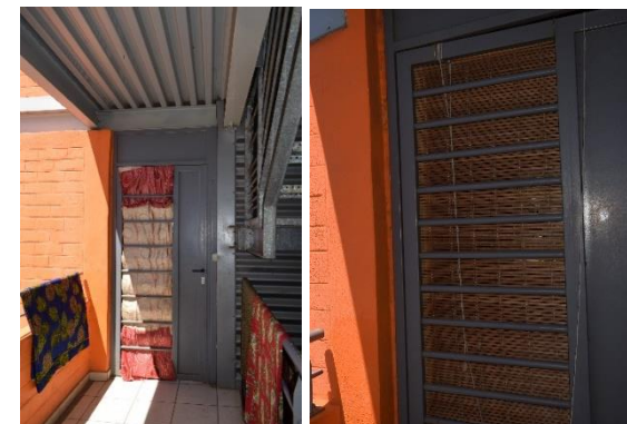
Opération Kenaparis : les portes grillagées donnent sur l'entrée de la varangue. Celles-ci ont été bouchées par des rideaux ou stores opaques pour préserver l'intimité des occupants.
