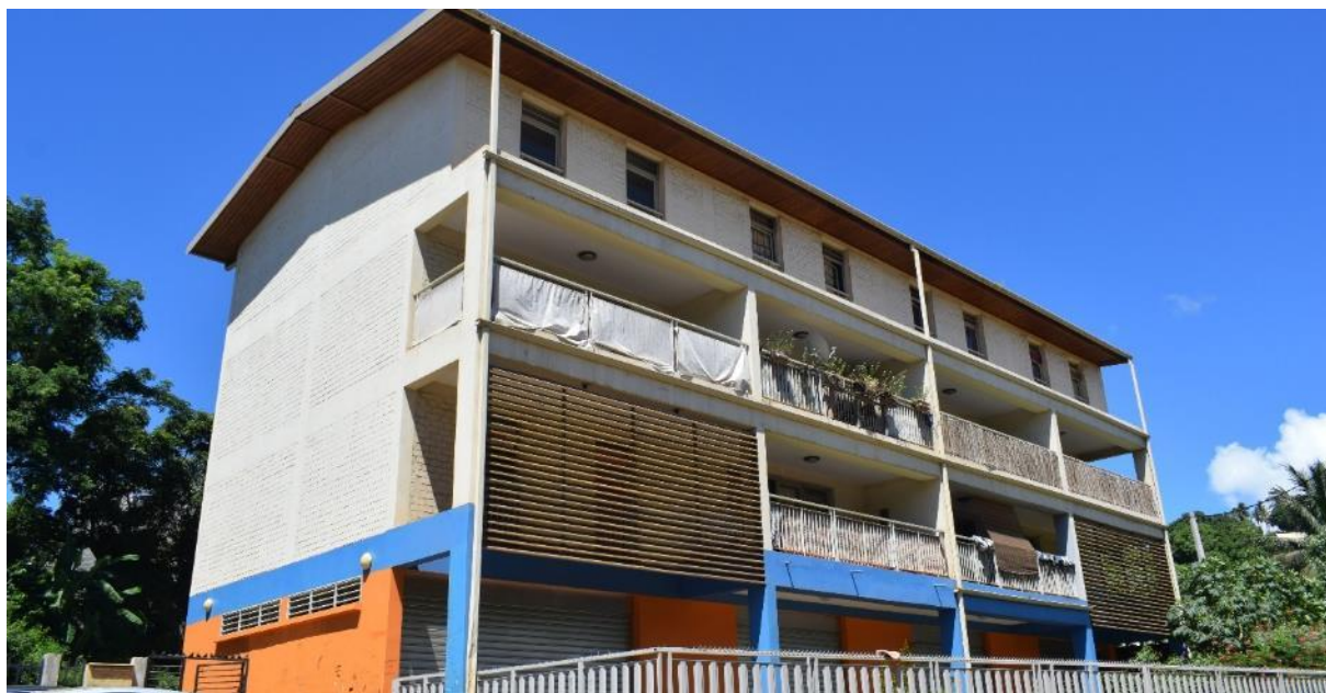
Façade nord sur rue
