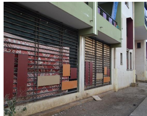
Opération Gemini : mise en œuvre de rideaux et stores intérieurs pour préserver l'intimité sur les varangues donnant directement sur la rue
