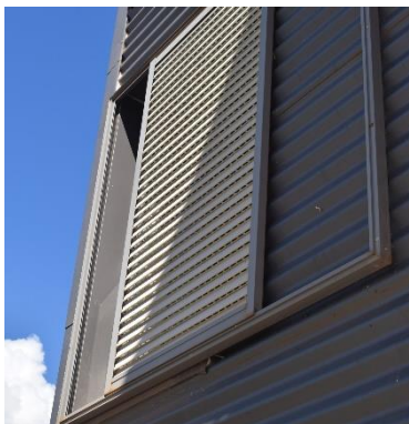
Opération Kenaparis : attention à la porosité des volets persiennés (très faible dans le cas présent)
