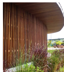
Bardage ventilé avec grand débord de toit
