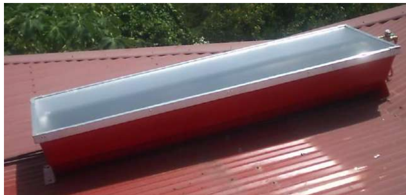
Figure 21 – Photo d'un capteur autostockeur (Source Solarinox Guadeloupe)
