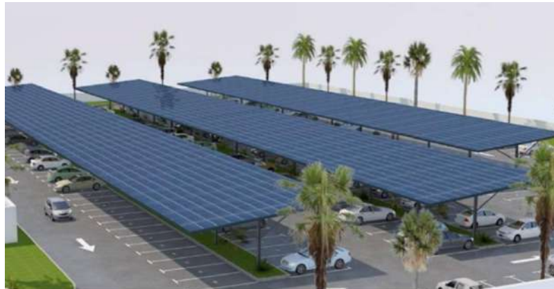
Figure 14– Exemple d'ombrière photovoltaïque
