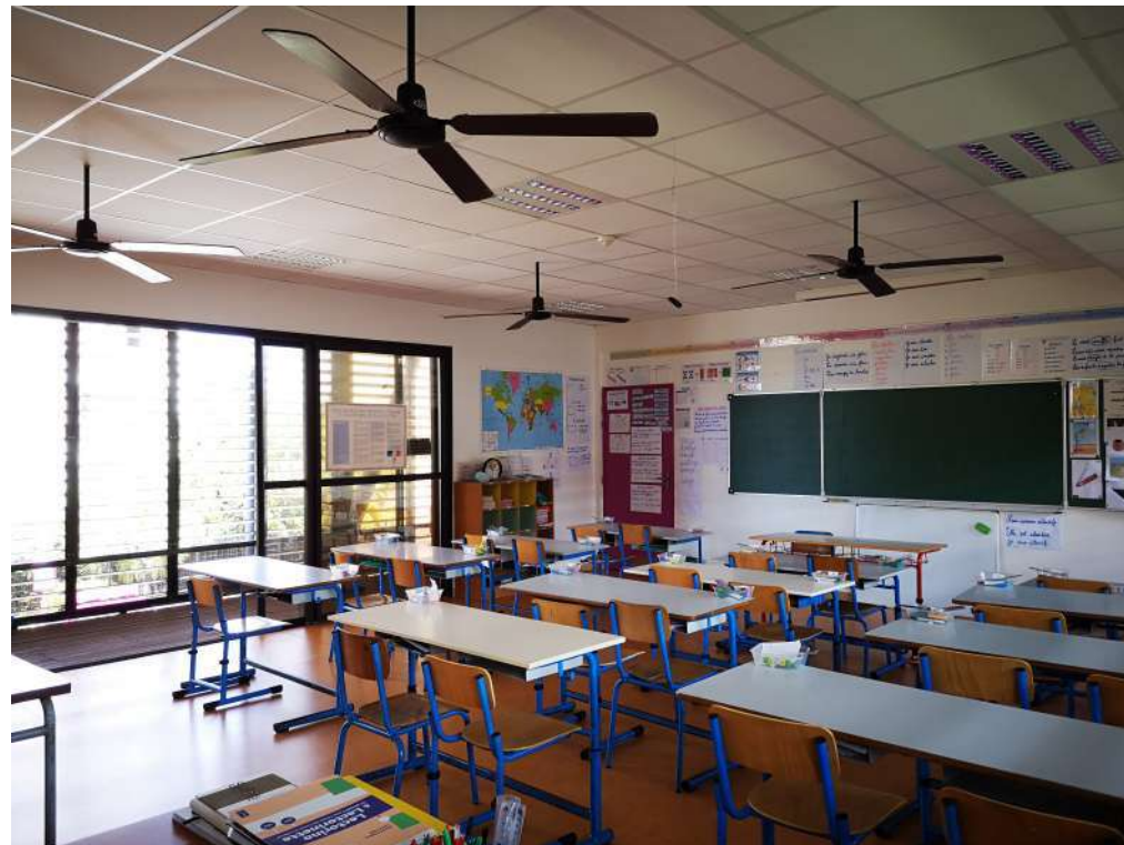
Salle de classe d'une école bioclimatique équipée de plusieurs brasseurs d'air efficaces avec commande individuelle.
