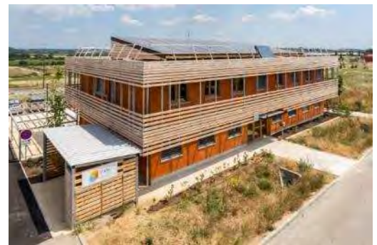
Figure 155 : Photo bâtiment de bureaux Izuba
