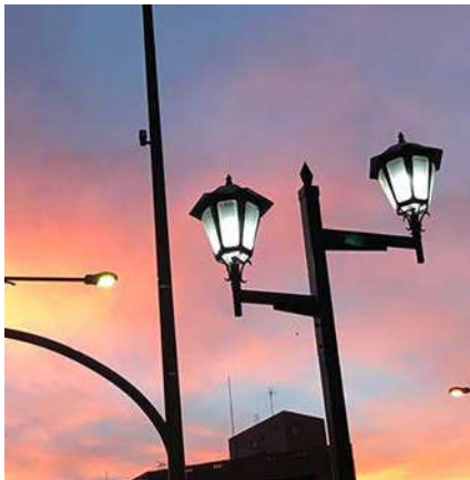
L'éclairage public de la ville de Niort
