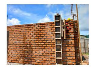
Date de livraison : 2023 Maîtrise d'ouvrage : Privée Maîtrise d'œuvre : GRZ Architecture BET Structure : SEIB Programme : Logements individuels Entreprise de maçonnerie : Sud Travaux Système constructif : remplissage BTC sur ossature béton Surface BTC : 166 m² (claustra compris) Classe BTC : 22 x 22 x 9,5 cm Phase : chantier
