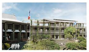
Date de livraison : 2024 Maîtrise d'ouvrage : Préfecture de Mayotte Maîtrise d'œuvre : Julien Beller Architecte (mandataire) BET Structure : INTÉGRALE Contrôleur technique : Veritas Entreprise de maçonnerie : PLAC OI Système constructif : remplissage BTC sur ossature bois Surface : 978 m² surface utile Surface BTC : 500 m² Classe BTC : 22 x 22 x 9,5 cm Montant prévisionnel des travaux : 5,5 M€ Phase : ACT
