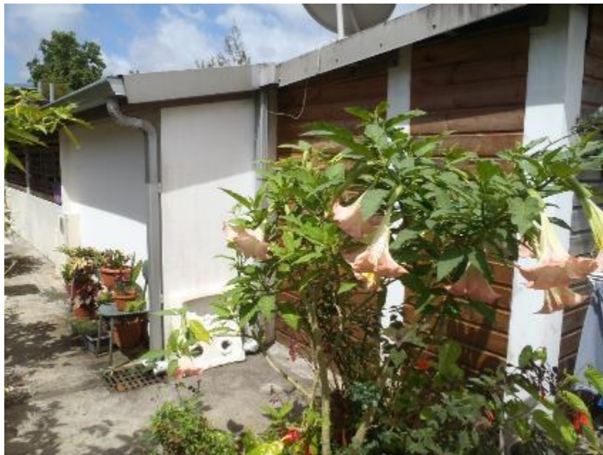
Photographie 5 : cliché OPTHY5 - Photo générale extérieur du bâtiment
