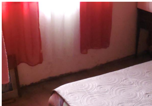
Photographie 15 : Traces d'humidité et de moisissure en pied de mur dues à une remontée capillaire importante
