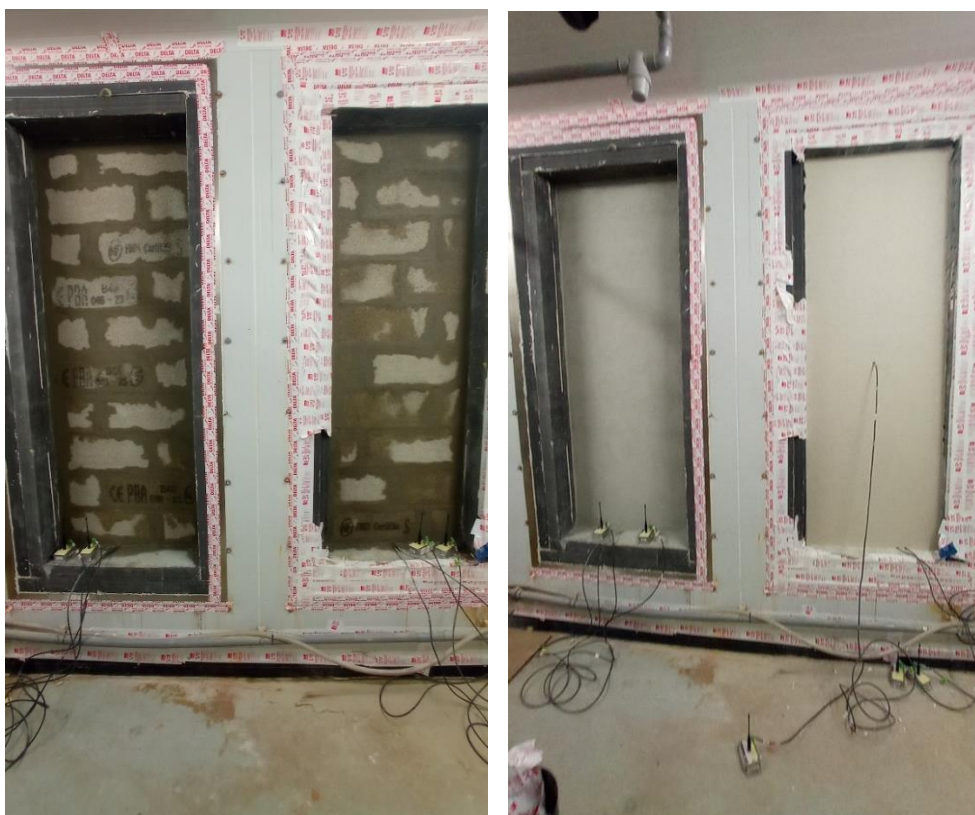
Photographie 9 : montage de la structure en parpaings pour les deux parois avec mise en place des capteurs de température et d'humidité relative (côté extérieur à gauche)
