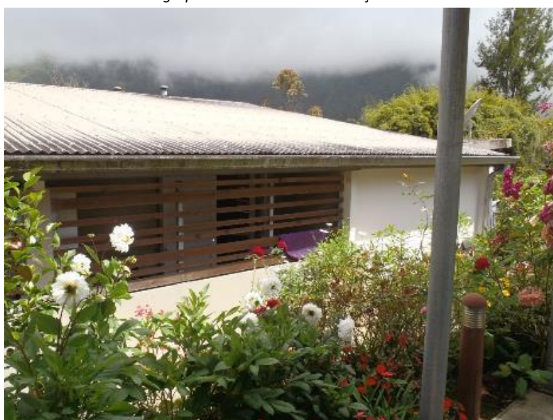
Photographie 7 : cliché OPTHY5 - Façade est
