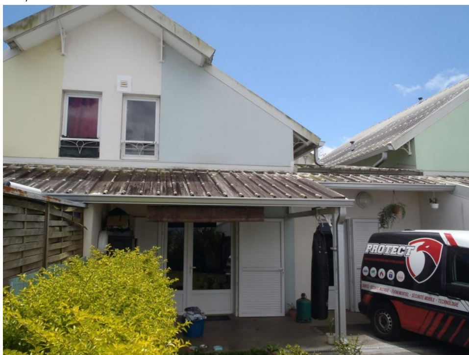
Photographie 14 : Façade Sud du logement OPTHY 2 dont l'orientation et les protections solaires ne permettent pas de bénéficier d'apports solaires
