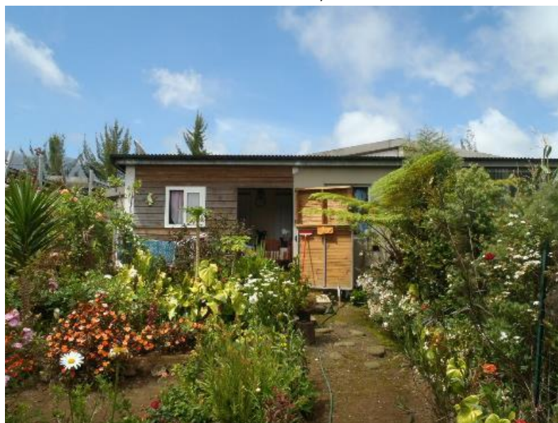
Photographie 6 : cliché OPTHY5 - Façade nord
