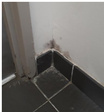
Photographie 15 : Traces d'humidité et de moisissure en pied de mur dues à une remontée capillaire importante
