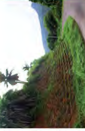
Mise en place de pneus qui maintiennent le versant
