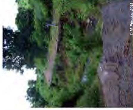
Portion de route emportée par un cours d'eau au niveau de Doujani
