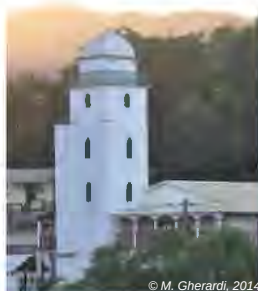
La mosquée de Mtsapéré
