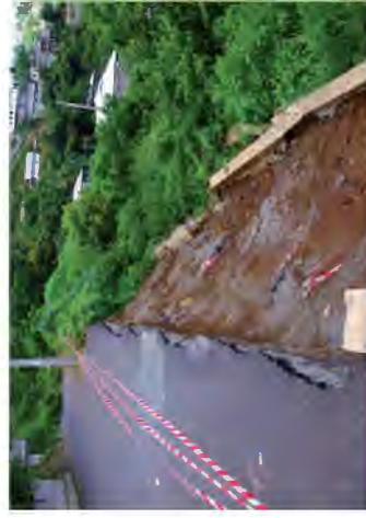
Affaissement d'une route à Sada dû au phénomène de régression de talus
