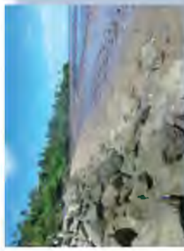
Enrochements sur le haut de plage
