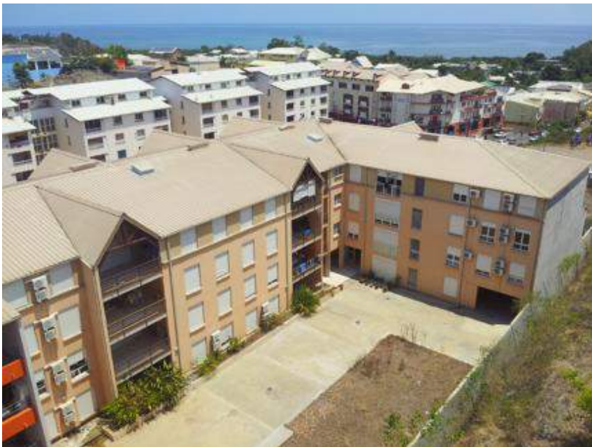
Figure 6-21 : Le quartier moderne des hauts Vallons est l'exemple parfait de protections solaires non adaptées. La protection par volet roulant empêche la ventilation naturelle et rend obligatoire l'utilisation de la climatisation.
