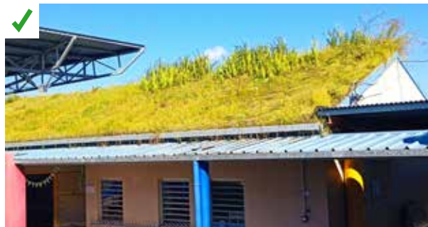
Mise en œuvre de modules végétalisés préfabriqués en surimposition d'une toiture en bac acier. ©AQC
