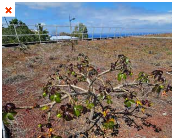
Une plante adventice peu dense s'est substituée à l'espèce initiale de type cynodon qui avait été choisie pour ses propriétés couvrantes. ©AQC
