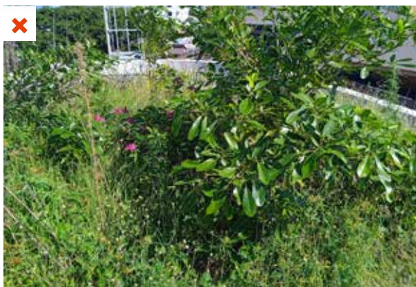
Développement spontané en toiture d'un arbre dont les racines perforent la membrane d'étanchéité à l'eau entraînant des infiltrations. ©AQC
