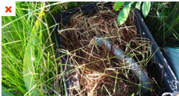
Développement de végétation à l'intérieur d'un regard. Aucun entretien n'est effectué et l'absence de couvercle n'a pas été corrigée. ©AQC
