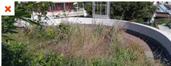
Absence de protection collective de type garde-corps et point d'ancrage isolé sans ligne de vie et peu visible dans la végétation. ©AQC
