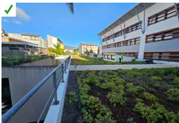
Site disposant d'un contrat d'entretien sur la végétalisation de toiture avec désherbage manuel, bouturage et apport nutritif si besoin. ©AQC
