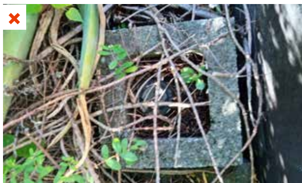
L'arrosage de la toiture n'est pas efficace, ce qui entraîne un risque de dégradation et de mortalité des végétaux. ©AQC
