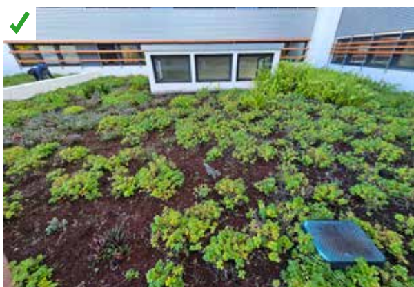
Contrôle du regard et des équipements intérieurs lors de la maintenance préventive générale de la TV (désherbage manuel, bouturage, etc.). ©AQC
