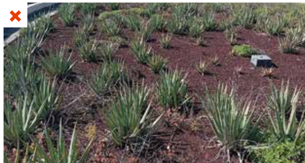
Faible couvert végétal avec intérêt esthétique et thermique limité. ©AQC
