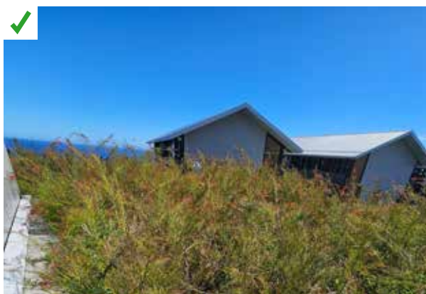
Toiture végétalisée isolée vis-à-vis du risque incendie avec bande stérile, point d'eau à proximité et d'accès simplifié. ©AQC
