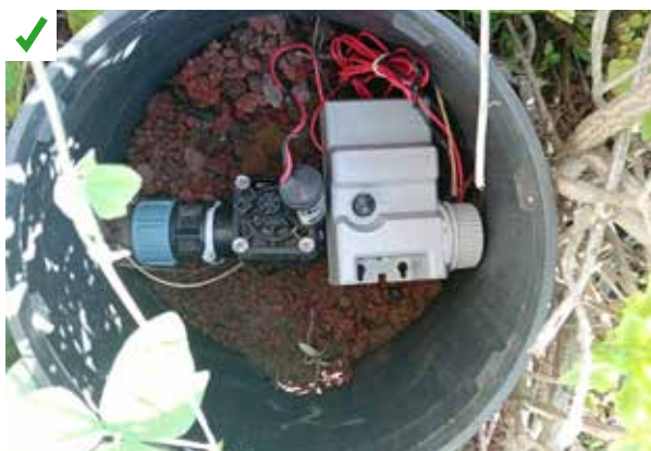
Programmeur bluetooth sur électrovanne permettant un pilotage de l'irrigation adapté aux besoins. ©AQC
