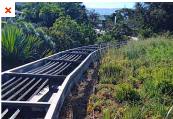
Des amas de végétaux séchés sont laissés en périphérie de la toiture végétalisée sur charpente bois. Ces végétaux constituent un combustible facilement inflammable. ©AQC
