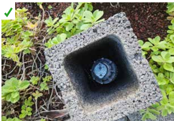
Buse d'arrosage automatique avec un quadrillage de la surface. ©AQC
