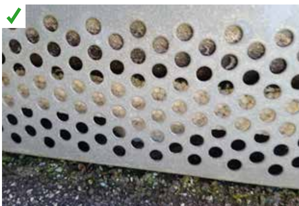
Cornières de séparation ajourées laissant passer le surplus d'eau de la couche drainante vers la zone stérile, puis les évacuations d'eau pluviale. ©AQC
