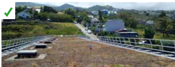
Garde-corps tout autour de la toiture pour des interventions sécurisées. ©AQC
