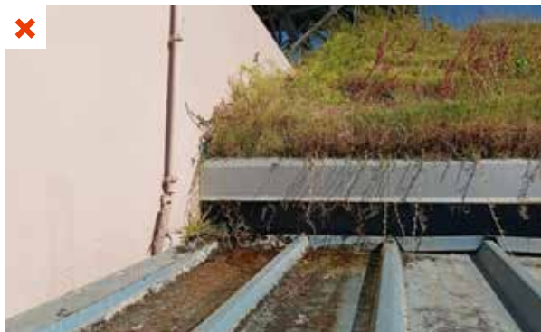
L'arrosage de la toiture végétalisée est en excès (dépassement de la CME) et déborde sur la toiture en dessous. ©AQC
