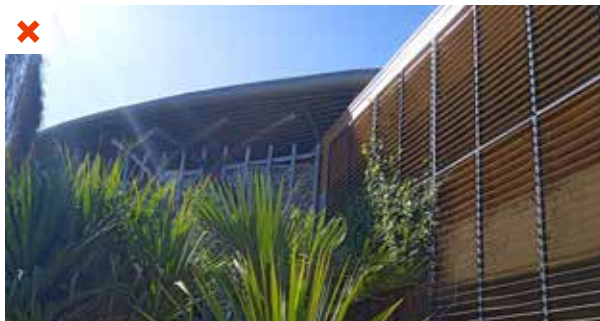
Toiture végétalisée non isolée vis-à-vis du risque incendie, sans accès facile et située en haut de la façade composée d'un brise-soleil composite. ©AQC
