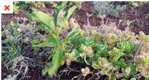
Développement d'une jeune pousse d'arbre d'avocatier marron dont les racines risquent rapidement de dégrader le dispositif d'étanchéité à l'eau de la toiture. ©AQC
