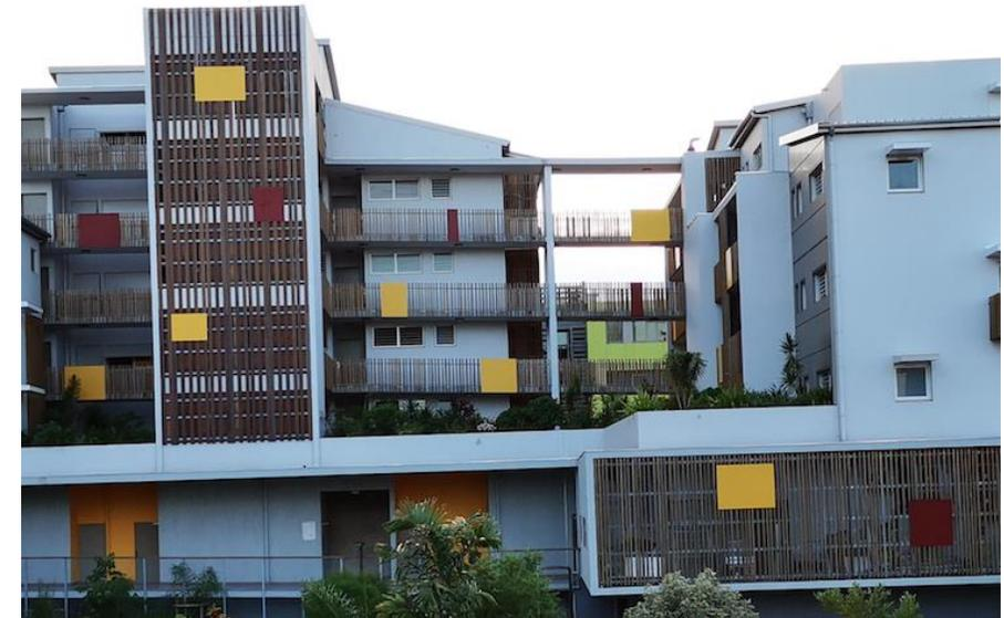
Modification des façades et des plans de cellules pour obtenir la ventilation naturelle traversante
