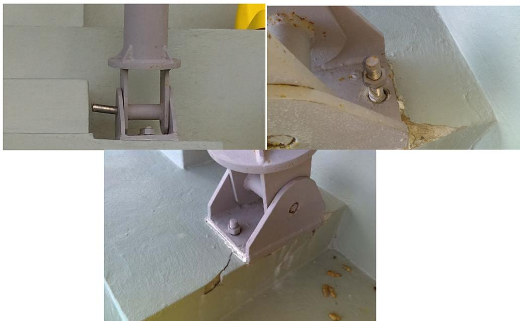
Figure 5.3-1 Photos illustrant le comportement fragile de l'ancrage d'un tirant de charpente d'une tribune à Marie Galante suite au passage du cyclone Maria (Photos P QUISTIN)
