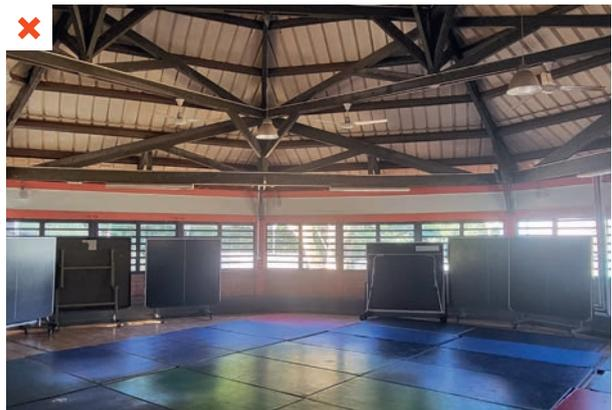
Le gymnase est couvert par une toiture en tôle blanche. La chaleur extérieure se diffuse rapidement à l'intérieur du gymnase. ©AQC
