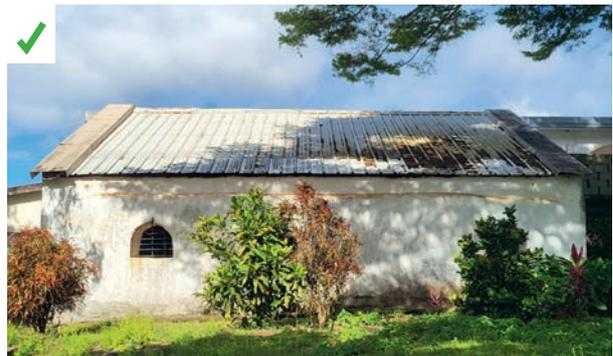
Les murs de la mosquée ont été construits au XVI<sup>ème</sup> siècle en pierre de corail. Le choix de ce matériau limite l'entrée de chaleur à l'intérieur de l'édifice. La conductivité thermique d'une pierre calcaire est en moyenne de  $\lambda : 3,5 \text{ W/m.K}$ . ©AQC
