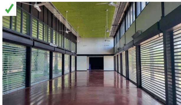
Dans cette pièce, conçue en ventilation naturelle traversante, le nombre, le diamètre et la puissance des brasseurs d'air sont adaptés à l'important volume de la pièce. ©AQC
