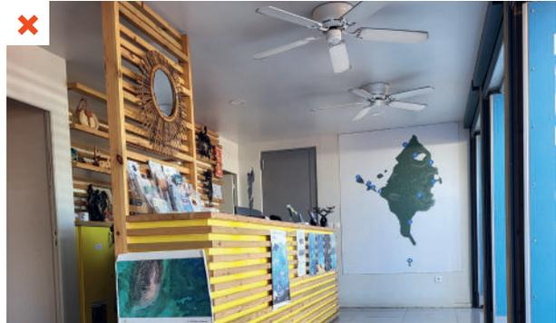
Dans ce bâtiment en structure légère, fonctionnant en ventilation naturelle, le personnel de travail ne bénéficie pas du mouvement d'air des brasseurs d'air. ©AQC
