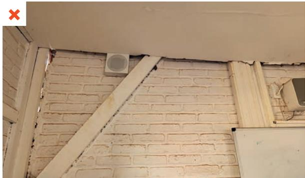
Altération du joint entre les BTC de remplissage et l'ossature porteuse en bois. ©AQC
