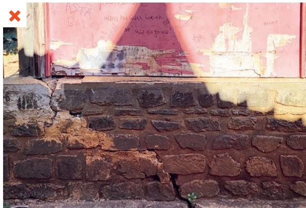
La rupture du soubassement en pierre menace la stabilité générale du mur. ©AQCC
