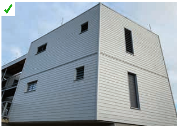
Rez-de-chaussée en béton associé à deux niveaux supérieurs d'habitation avec couverture intégralement construits en ossature bois et bardage bois. Ce dispositif respecte les normes parasismiques et paracycloniques en vigueur. ©AQC
