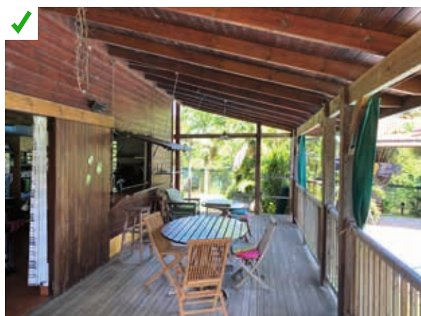
Présence d'une zone tampon (véranda) entre l'intérieur et l'extérieur du bâtiment. ©AQC
