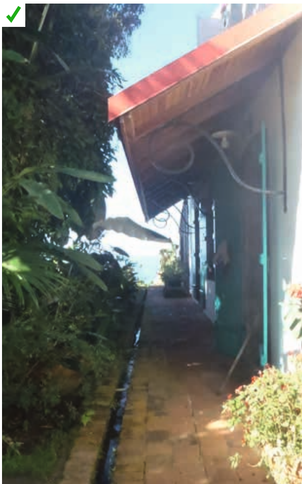
Chemin d'eau originel préservé. ©AQC
