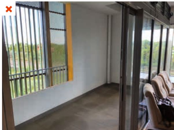
Espace de transition non fonctionnel, car ne protégeant pas efficacement des pluies ou du rayonnement solaire. ©AQC
