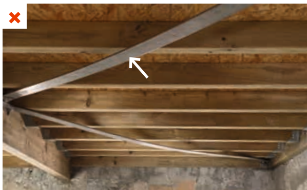
Compression anormale des éléments de contreventement. ©AQC
