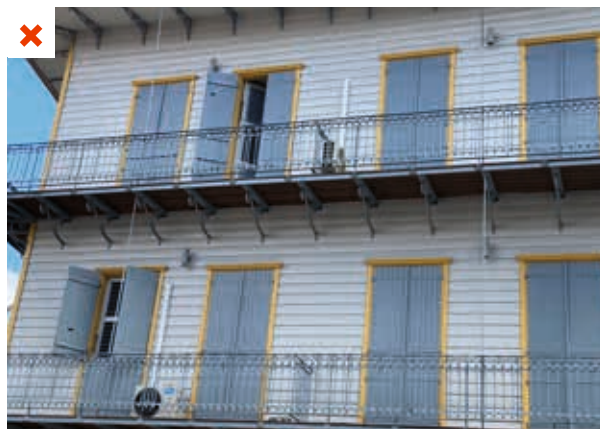
Unités extérieures des climatiseurs installées en façade sans emplacement spécifique ou de protection adéquate. ©AQC
