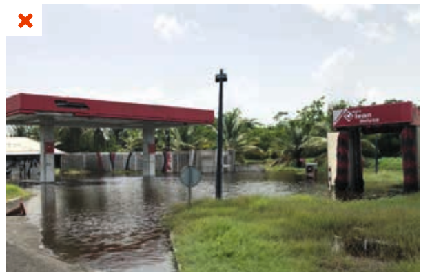
Équipement implanté en zone inondable. ©AQC
