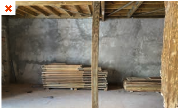
Flambage d'un poteau reprenant les charges d'un étage vide. ©AQC
