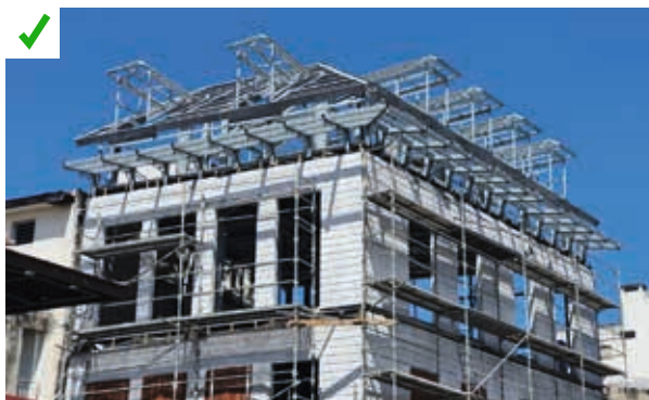
Mise en place d'une structure métallique lors de la réhabilitation du bâtiment et du réagencement des espaces intérieurs pour répondre aux besoins de confort et aux normes actuelles (électrique, thermique, risques majeurs) tout en gardant l'aspect architectural et patrimonial de l'ouvrage. ©AQC
