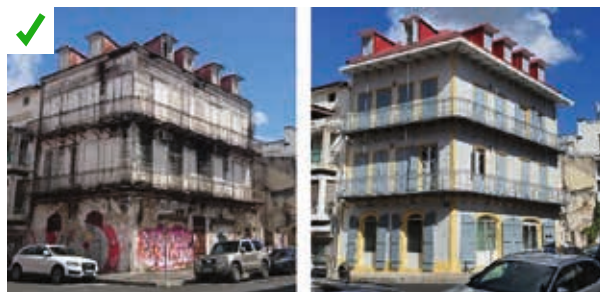
Rénovation d'une maison bourgeoise en centre ancien. Reconstruction à l'identique en ajoutant une couverture sur le balcon en R+2 avec l'accord préalable de l'Architecte des Bâtiments de France (ABF).
