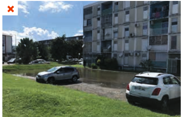
Inondation en pied d'immeuble suite à de fortes précipitations entraînant des dégradations au rez-de-chaussée. ©AQC
